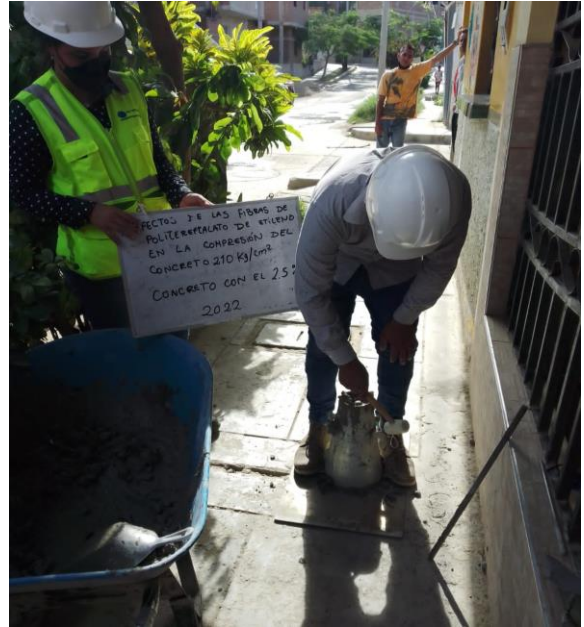
Figura 28: Rasado del concreto
