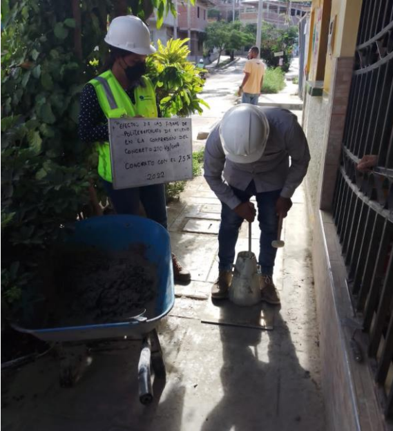
Figura 27: Varillado del concreto
