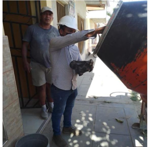
Figura 24: Adicionando las fibras PET al concreto
