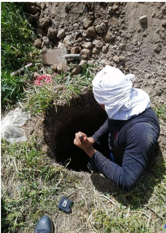
Figura 41. Excavación de calicatas
