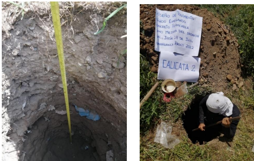
Figura 10. Realización de Calicata - C-2
