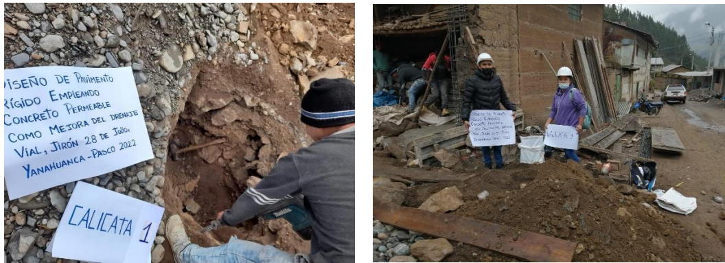
Figura 9. Realización de Calicata - C-1
