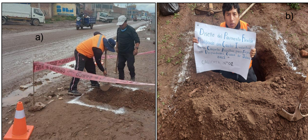
Figura 16. Excavación calicata C-2 a) Inicio de excavación b) Proceso de excavación Fuente: Propia del investigador
