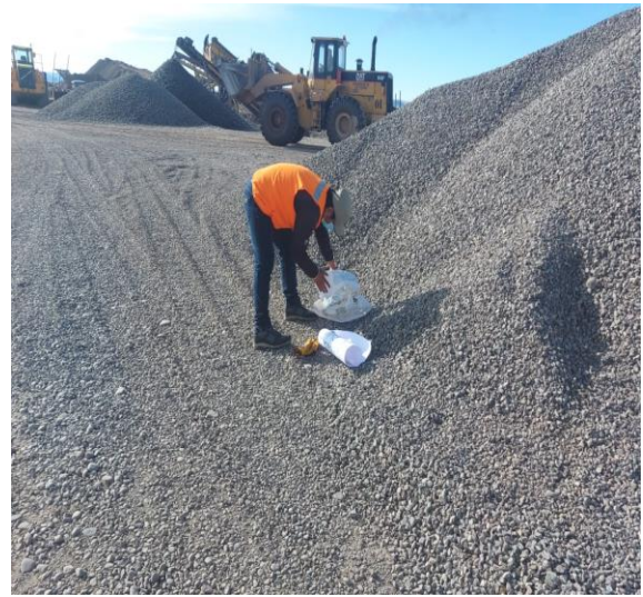
Figura 54. Obtención de la piedra chancada.
