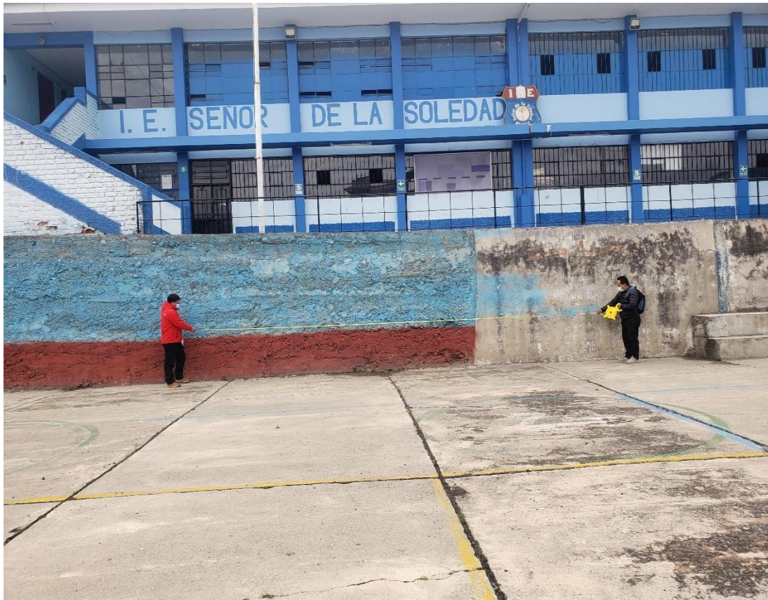
Equipo investigador observando y realizando los procesos de medición de las áreas con presencia de patologías de las estructuras en un muro de la institución educativa señor de la soledad de la ciudad de Huaraz.
