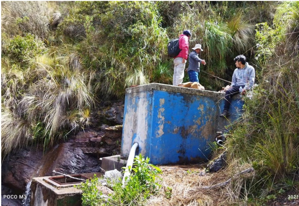
Foto 5: Tubería de limpia
