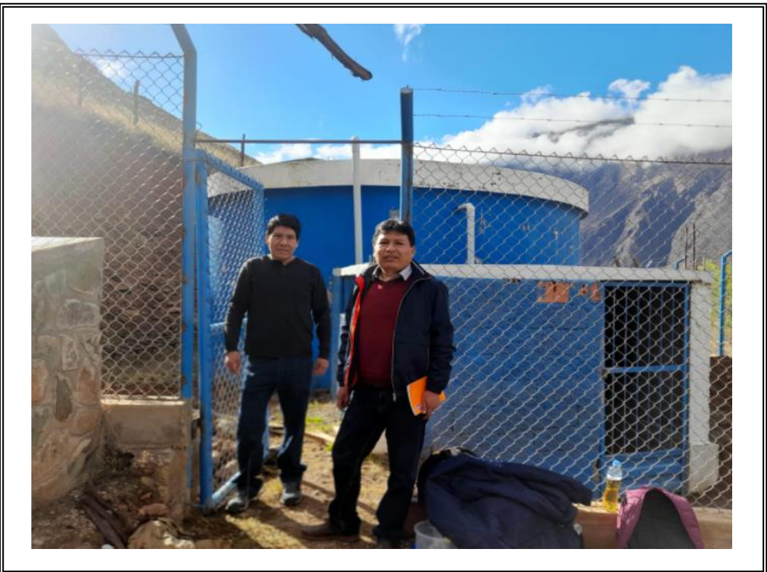
Foto 16: Reservorio N° 2 de 95 m 3
