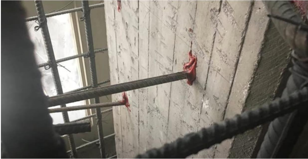
Figura 13. Encamisado y sus anclajes al elemento existente
