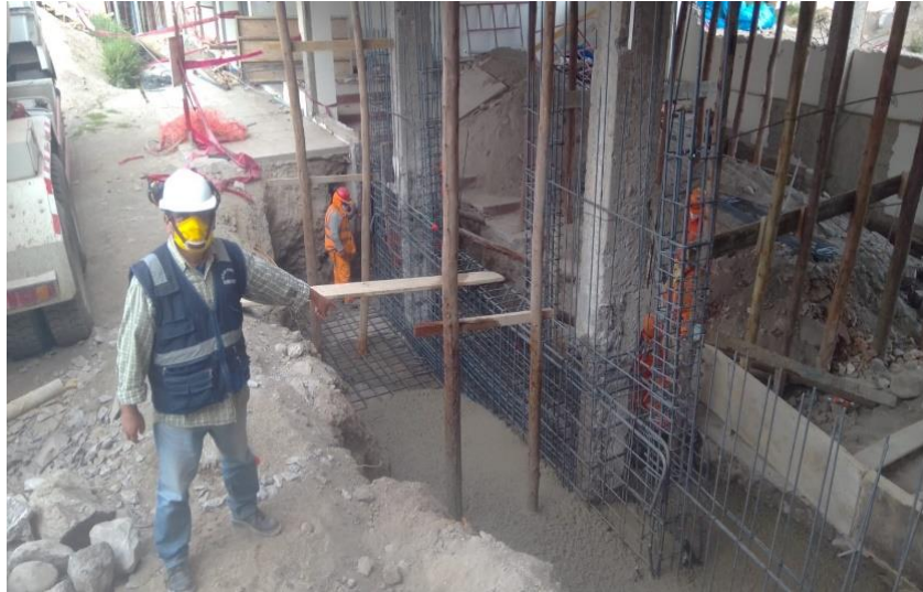
Figura 51. Foto de proceso de colocación de acero vertical y horizontal para reforzamiento.
