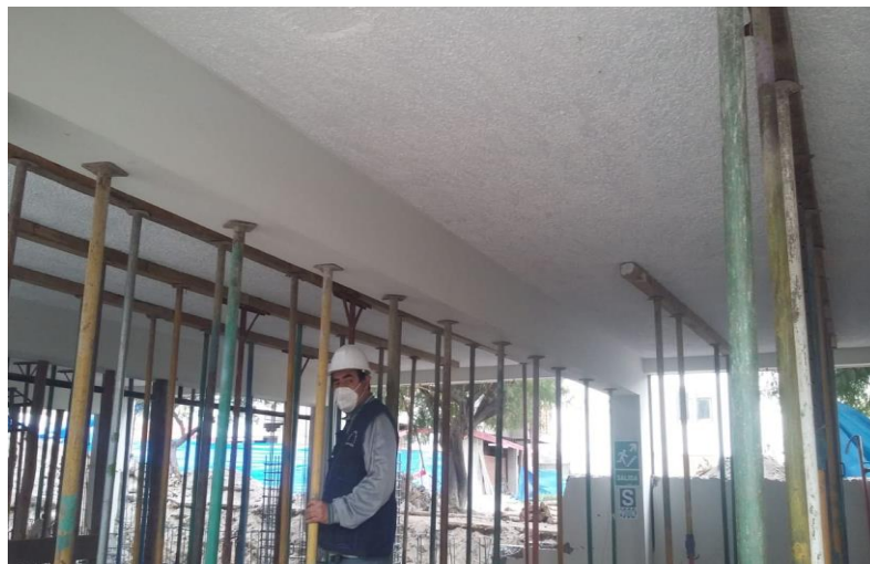
Figura 50. Foto de proceso de Apuntalamiento para reforzamiento.
