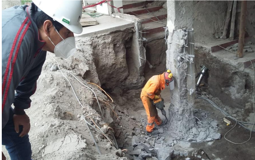
Figura 149. Foto de proceso de descubrimiento de concreto para reforzamiento.
