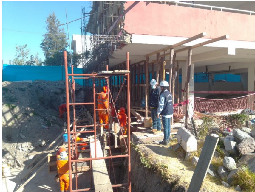
Figura 53. Foto de proceso de vaciado de concreto en reforzamiento, técnica encamisado.
