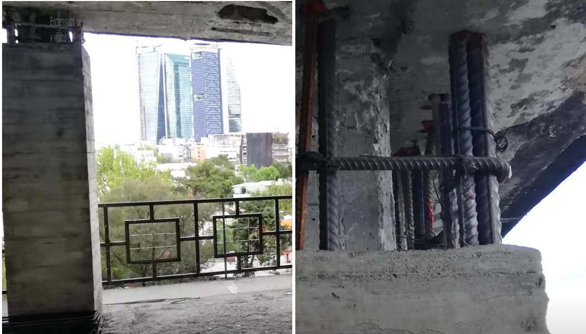
Figura 4. Encamisado de viga, columnas y nudos con concreto reforzado
