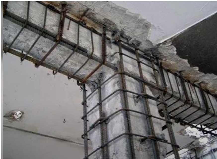
Figura 15. Encamisado en nudo (viga/columna)
