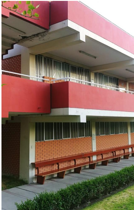
Figura 16. Vista de pasillo en fachada posterior
