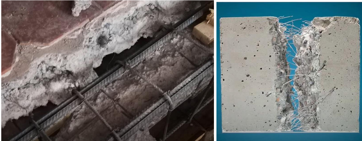
Figura 6. Elementos de refuerzo con acero de construcción y/o concreto-mortero con fibra
