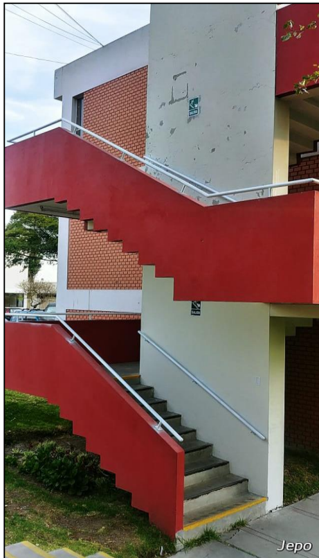
Figura 17. Vista frontal de escaleras del pabellón existente
