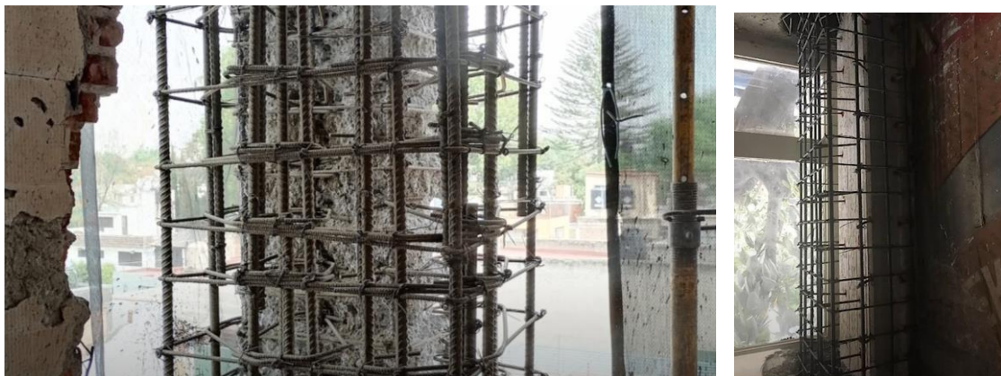
Figura 52. Foto de proceso de reforzamiento de columna existente con acero
