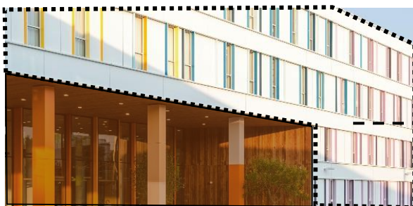
Figura N°46 Vista Externa desde el Ingreso
