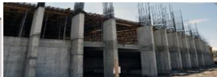
Se forma una serie de soportes verticales que funcionan como estructuras eliminando las columnas internas
