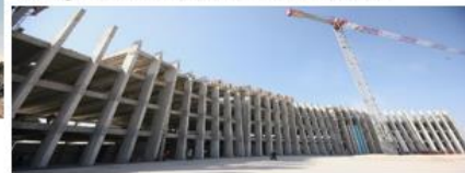
1 ESTRUCTURA DE HORMIGON ARMADO 2 SISTEMA DE DRENAJE EN LA CUBIERTA 3 TECHO LIBIANO DE POLICARBONATO
