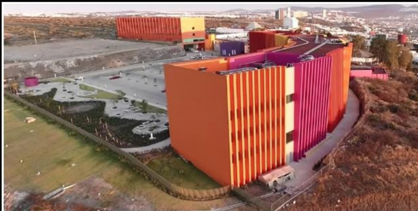
VISTA AEREA DEL EQUIPAMIENTO
