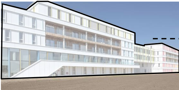
Figura N°45 Vista Peatonal Lateral del Exterior
