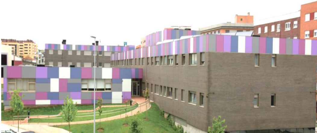
Imagen N° 1: “La Casa Malva” - Fachada Principal
