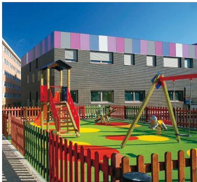
Imagen N°4: Casa Malvan - Patio de Juegos
