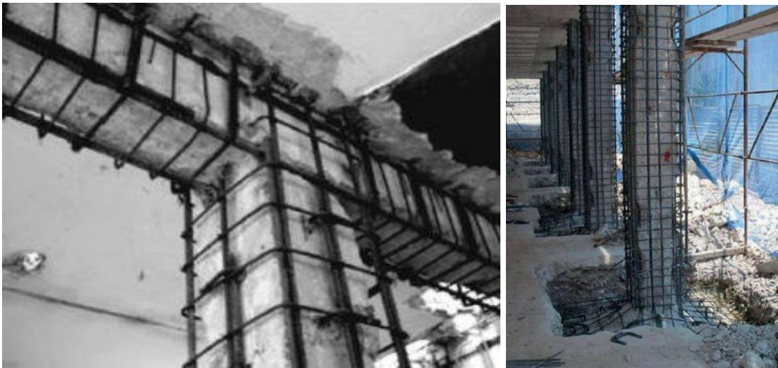
Figura 79. Encamisado de columnas
