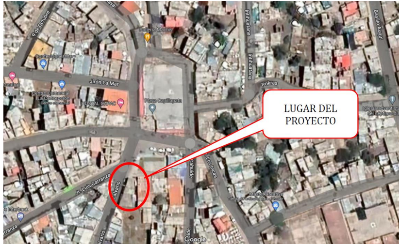
Figura 41. Ubicación de la edificación
