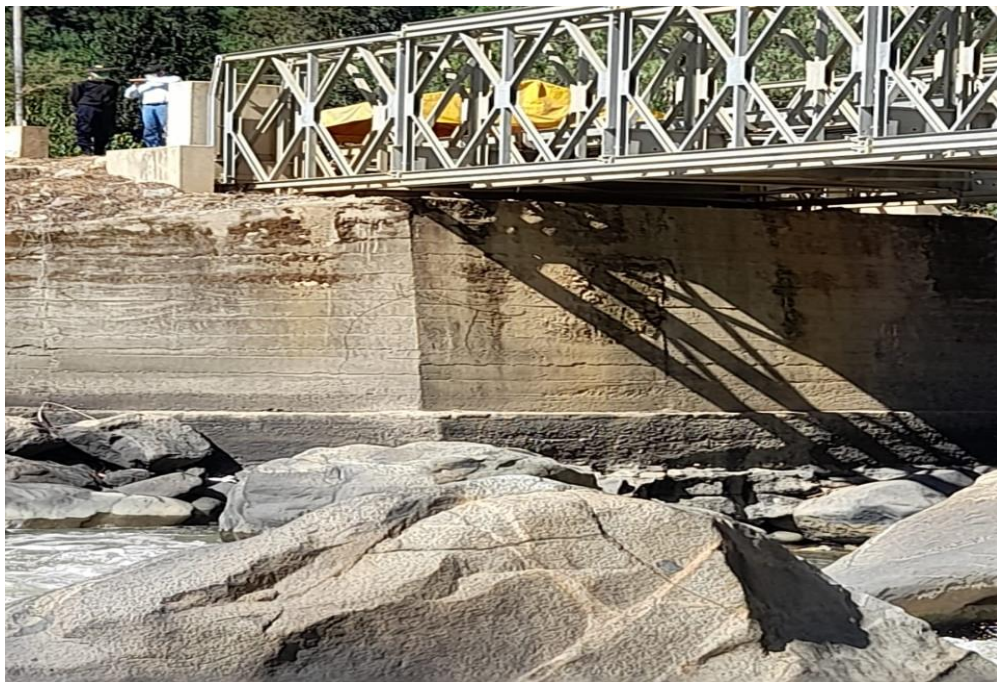
Figura 11: Cimiento del estribo Derecho tomada desde la superficie
