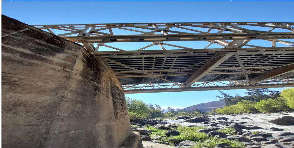
Figura 06: Estribo derecho tomada desde el nivel del agua
