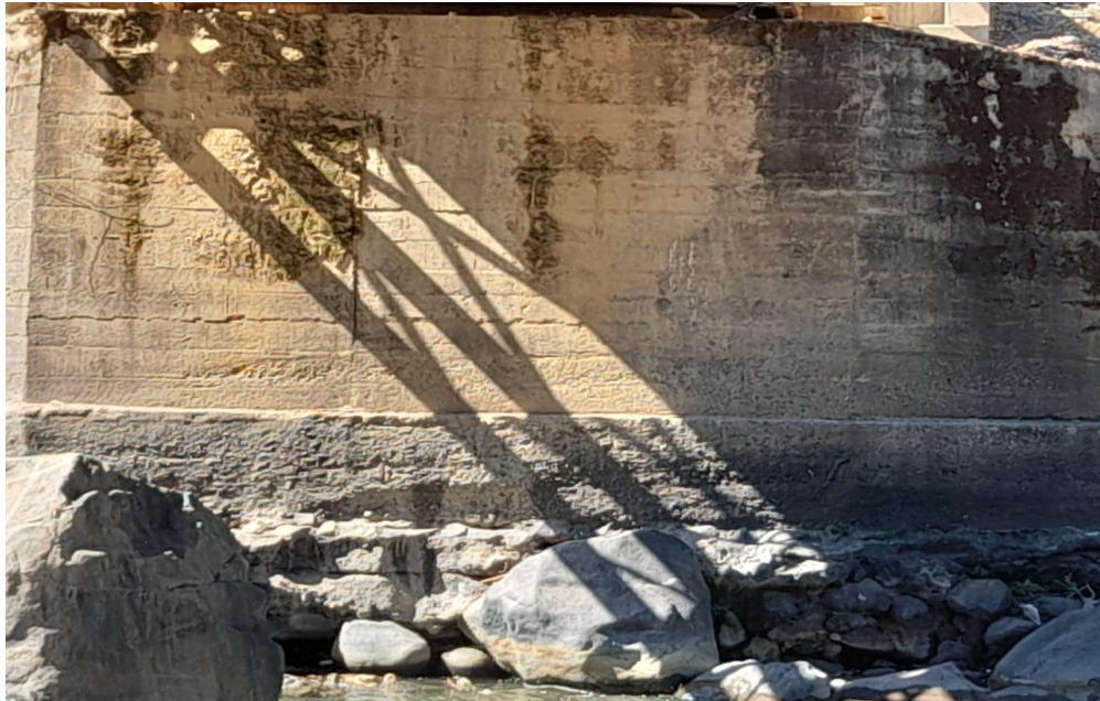
Figura 10: Cimiento del estribo derecho tomada desde el nivel del agua
