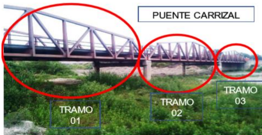
Figura 01. Tramos del puente a inspeccionar.
