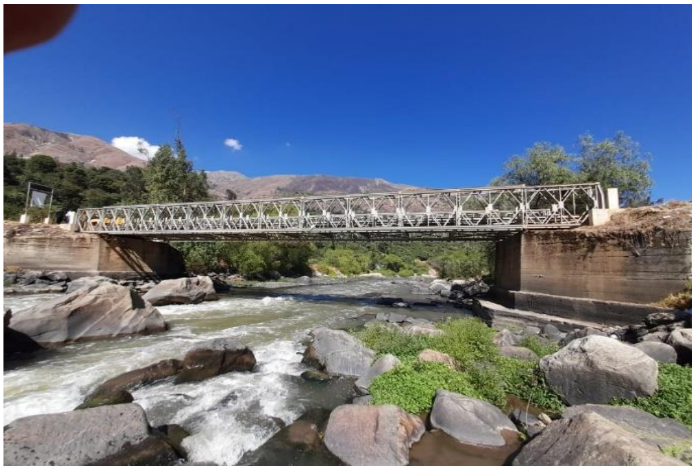
Figura 07: Estribo derecho tomada desde la superficie del puente
