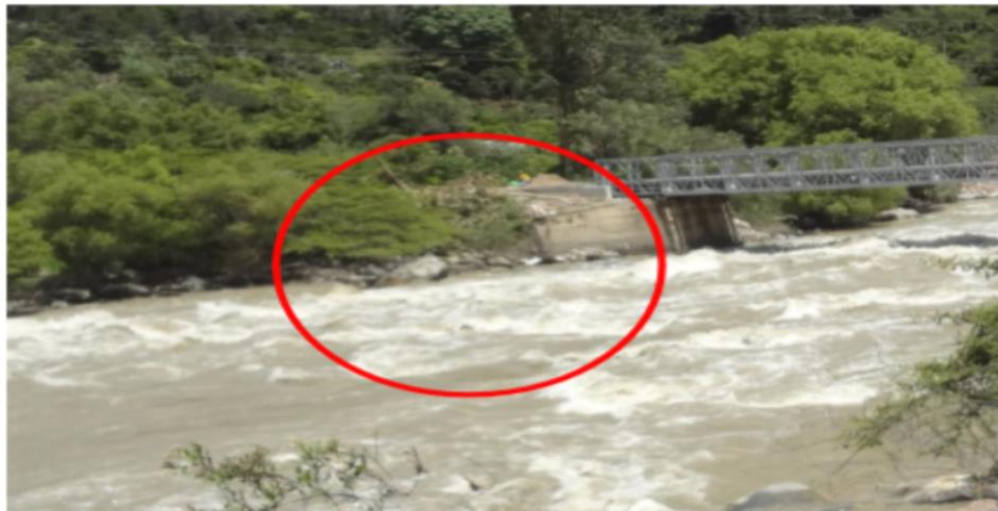
Vista zona ubic. Estribo Izquierdo presencia de boloneria
