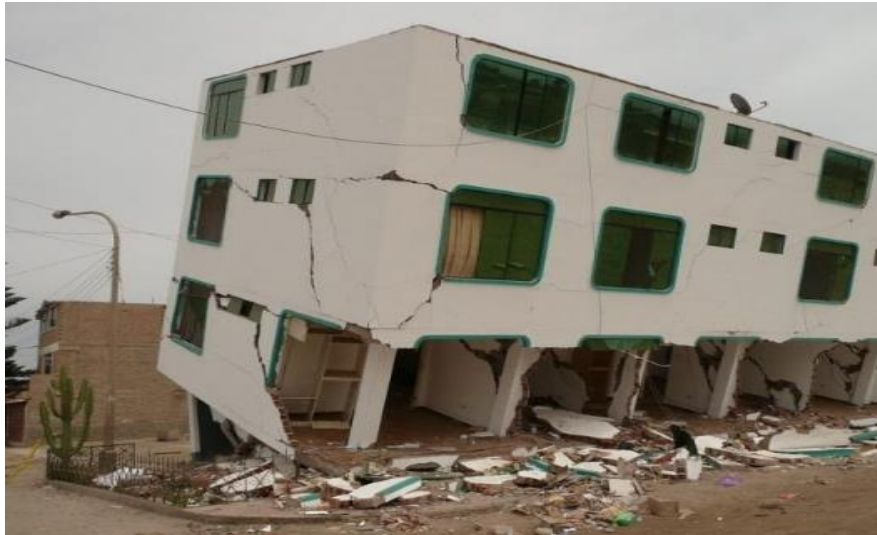
Figura 4 Vivienda de albañilería tres pisos después de un terremoto del 2007 Pisco
