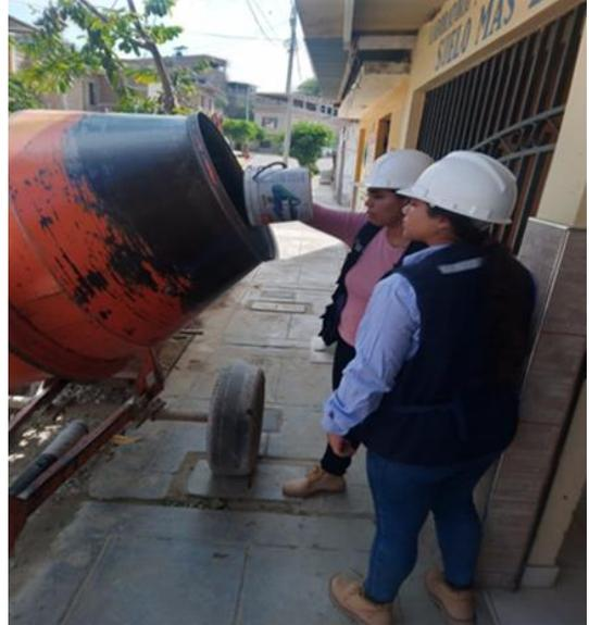
**Figura 70:** Agregando materiales al trompo
