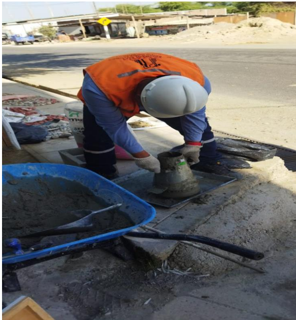
Figura 58: Levantamiento del cono
