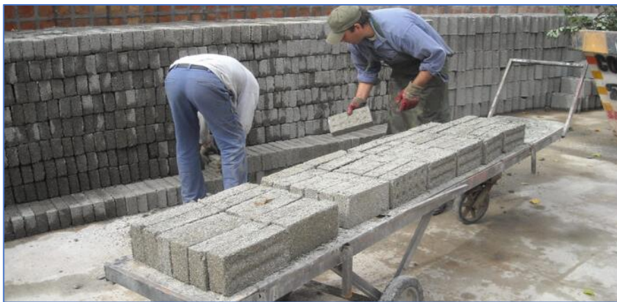
Figura 5: Los ladrillos con adición de fibras PET pierden menos material
