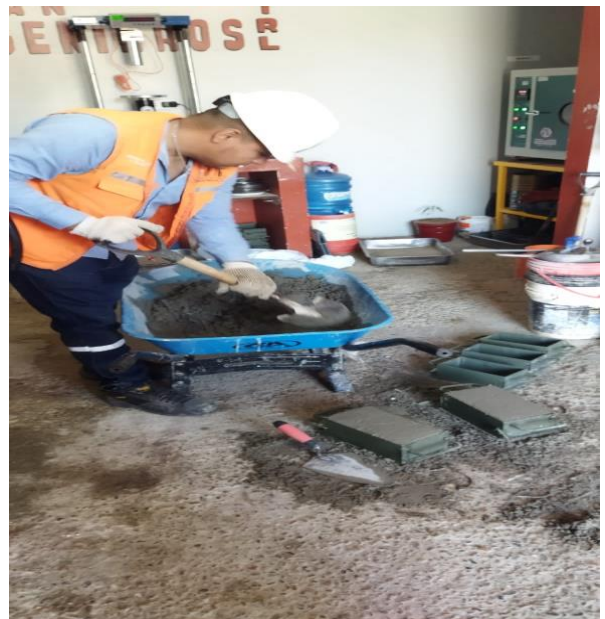
Figura 66: Elaboración de ladrillos
