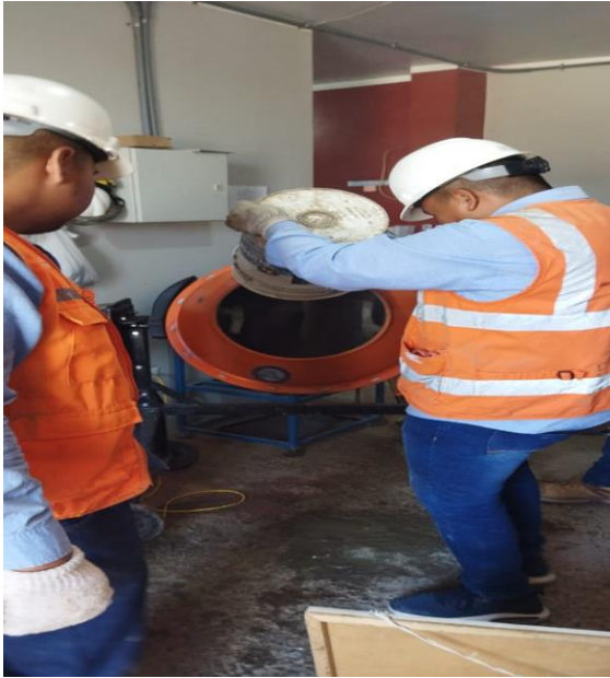
Figura 48: Vaciado de agregado al trompo
