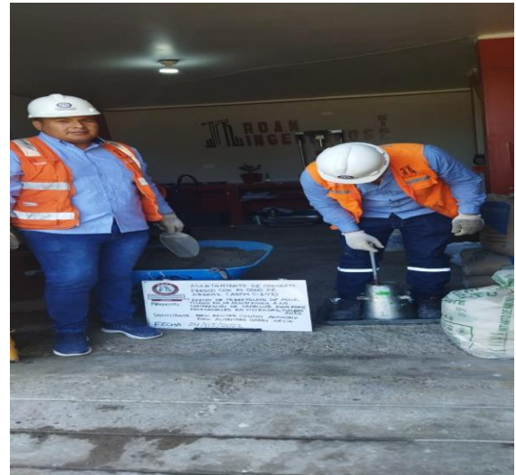
Figura 57: Varillado del concreto
