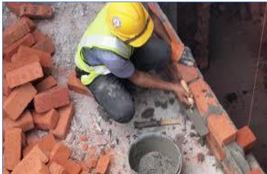
Figura 6: Muro construido empleando ladrillo artesanal cocido
