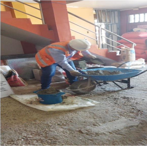
Figura 52: Llenado de olla con concreto
