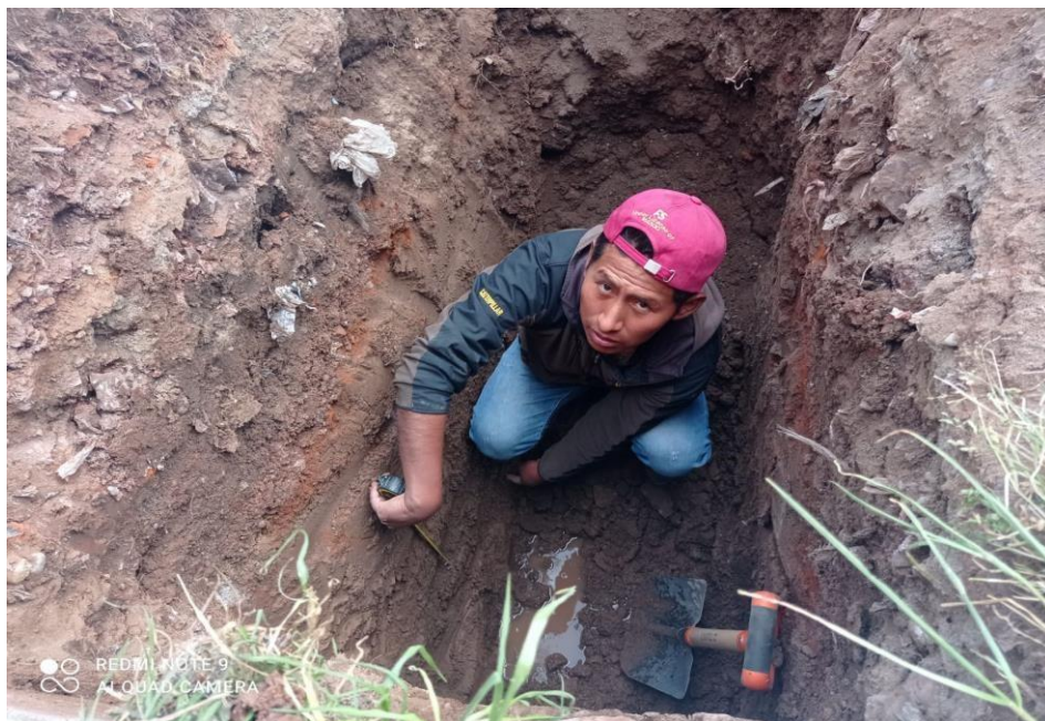
Se muestra la calicata.
