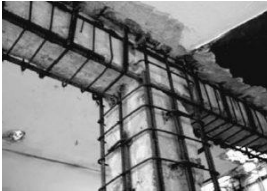
Figura 7. Encamisado de vigas y columnas
