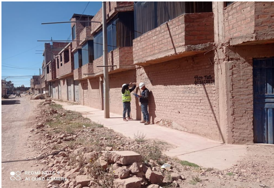
Ensayo de esclerómetro.
