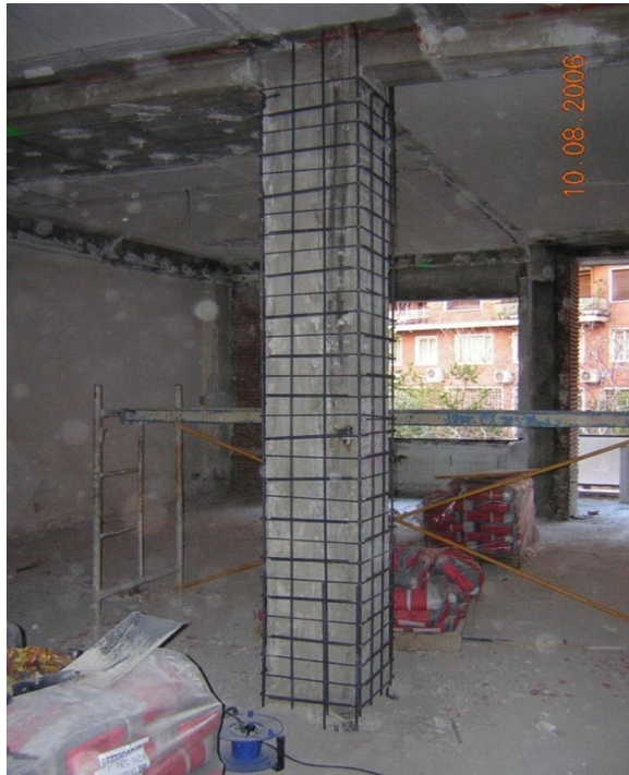
Figura 5. Encamisado de columna
