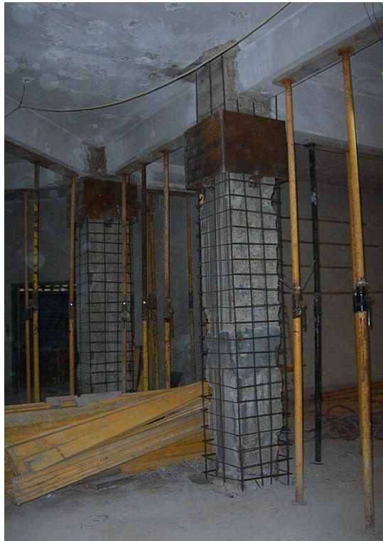
. Figura 6. Ensanchamiento de columnas
