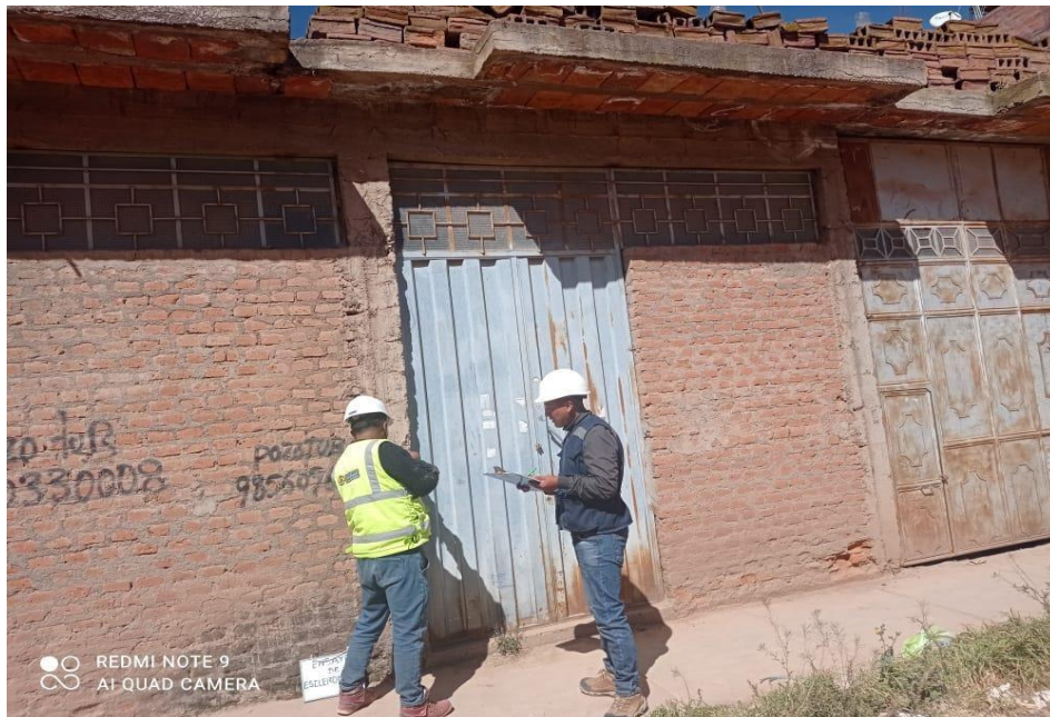
Ensayo de esclerómetro en columna.
