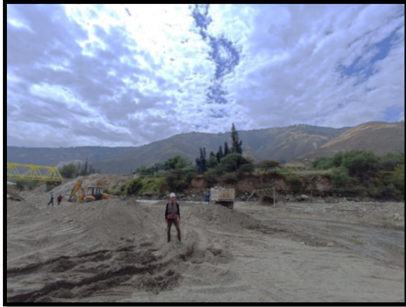
Extracción de muestra de agregado grueso y fino – Cantera Cátac - Recuay
