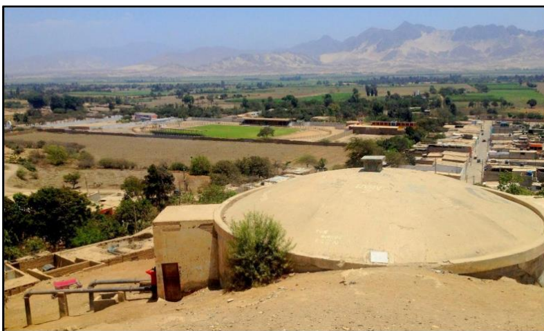
Anexo F6. Vista del reservorio de agua potable municipal del distrito de Ascope
