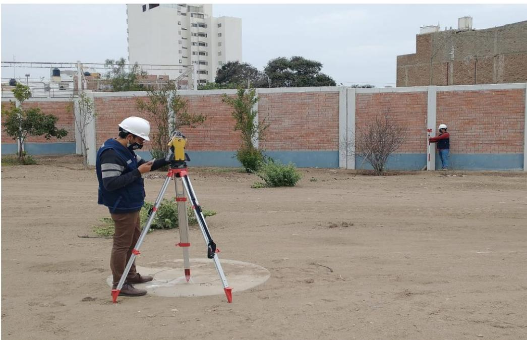
**Levantamiento topográfico mediante estación total**
