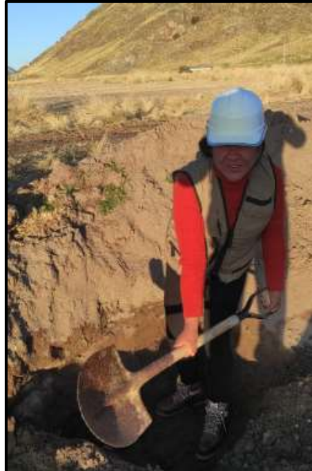
Figura 11. Excavación de calicata Fuente: propia
