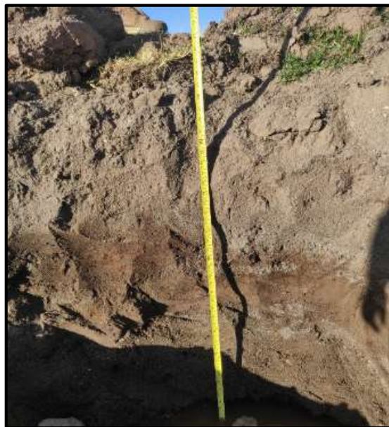
Figura 12. Medición de la altura de calicata Fuente: propia
