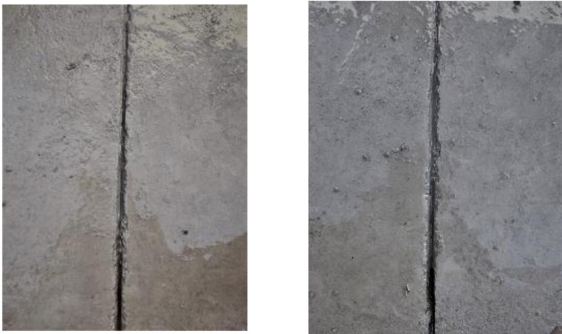
Figura 21: aserrado número 1, con presencia de desmoronado
