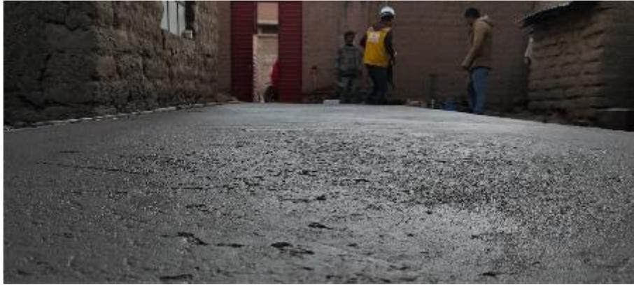
Figura 11: regleado en la losa de concreto simple
