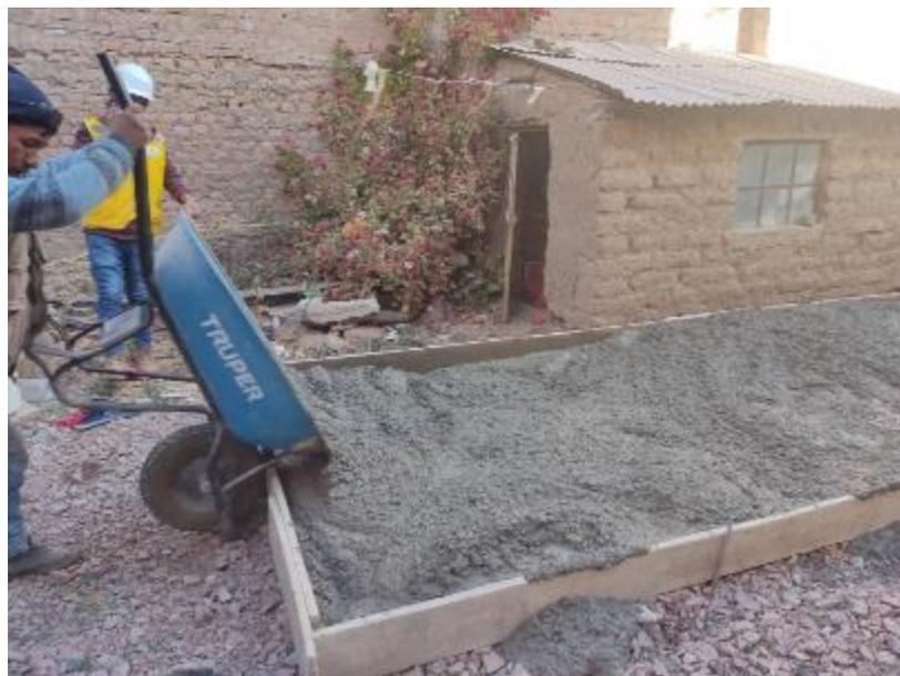
Figura 8: vaciado de concreto en losa
