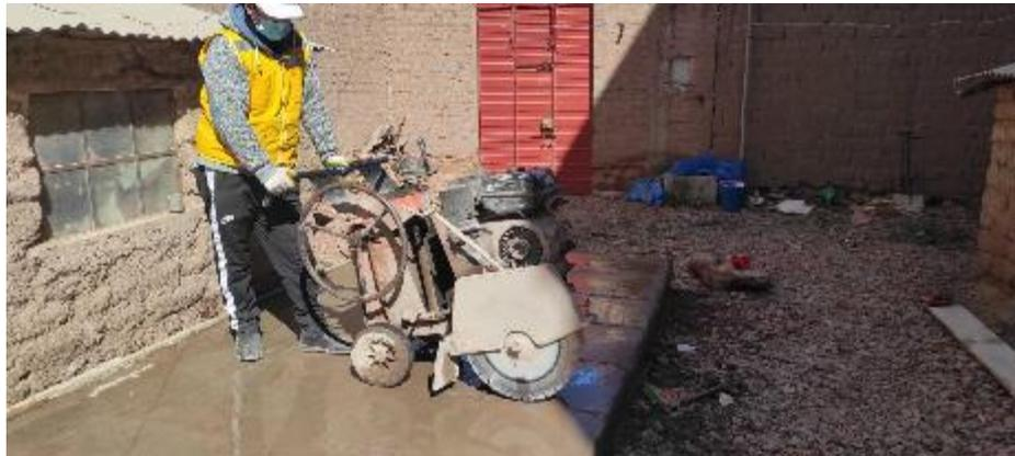
Figura 17: operador de equipo de corte realizando el aserrado
