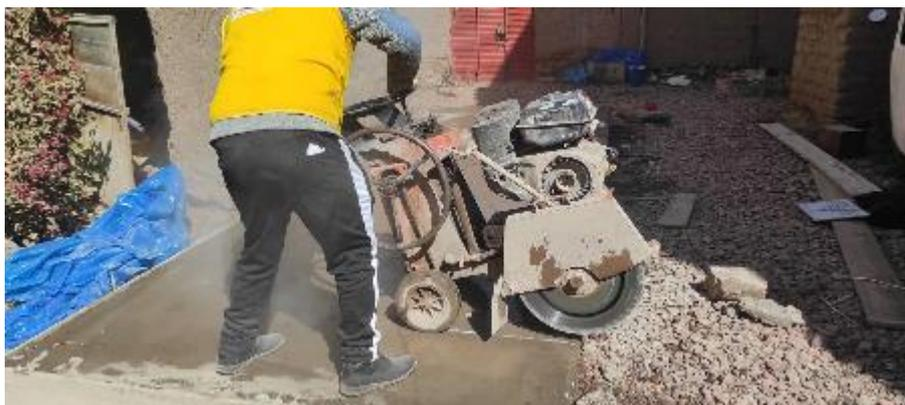
Figura 18: operador de equipo de corte realizando el aserrado
