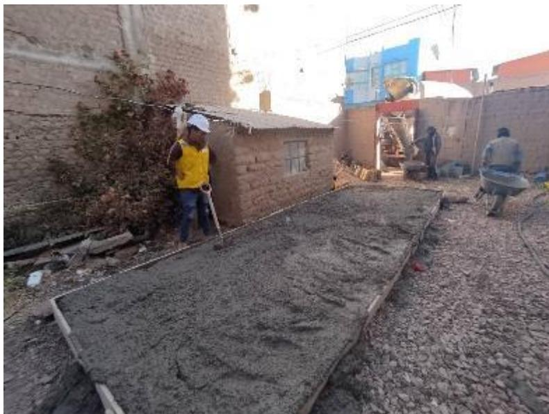
Figura 10: vaciado de concreto en losa
