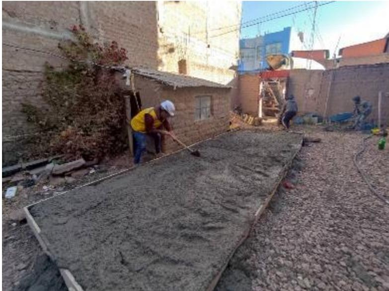
Figura 9: vibrado de concreto en losa
