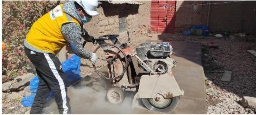
Figura 16: operador de equipo de corte realizando el aserrado
