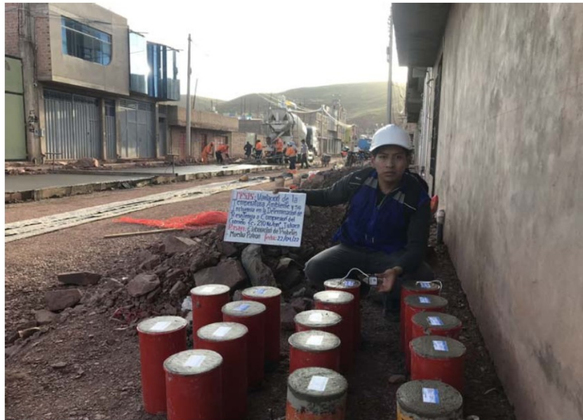
Fotografía 13. Instalación de sensores SmartRock2 - Muestra no sumergida in situ (A)
