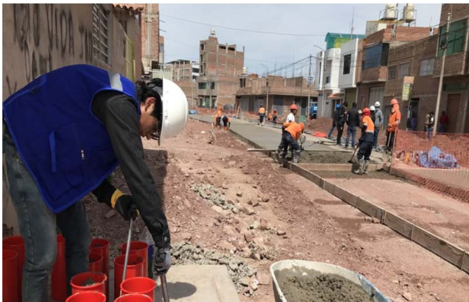
Fotografía 4. Elaboración de probetas - Muestra Patrón (P)
