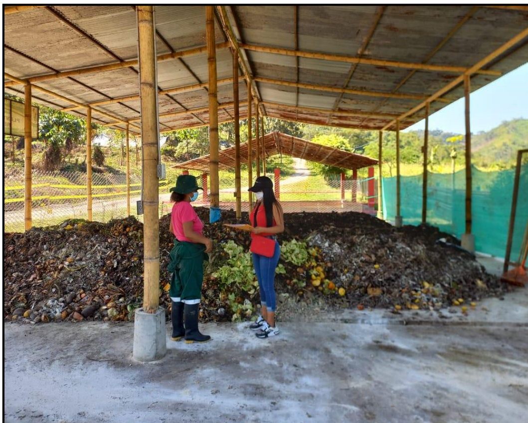
Fotografía N°4. Planta de Valorización de Residuos Orgánicos.
