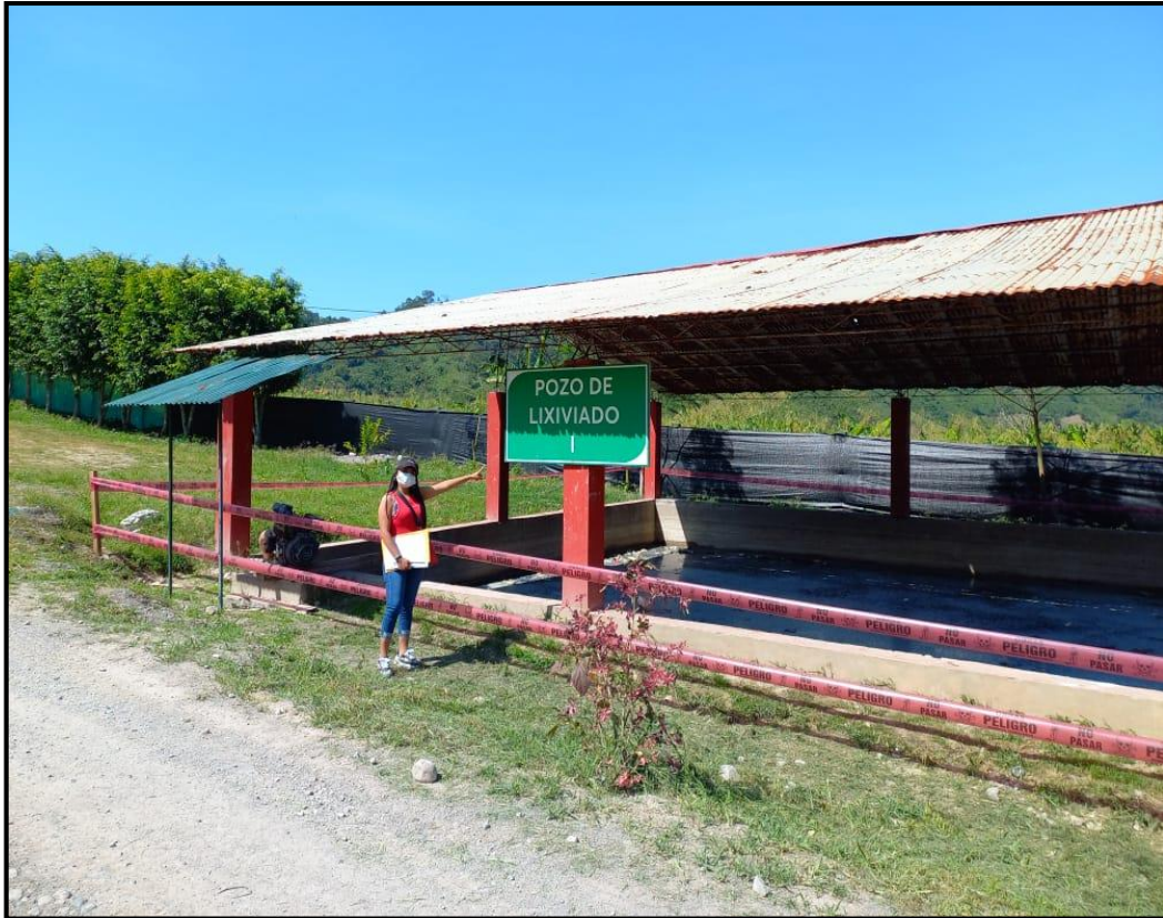
Fotografía N°3. Pozo de Lixiviados de la Planta de Tratamiento de RS.
