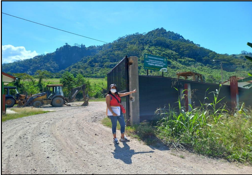
Fotografía N°1. Ingreso a la Planta de Tratamiento de RS “Pampa Americana”.
