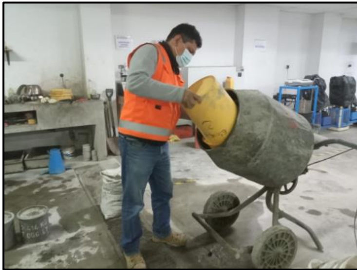
Figura 19. Dosificación de los agregados para la mezcla
