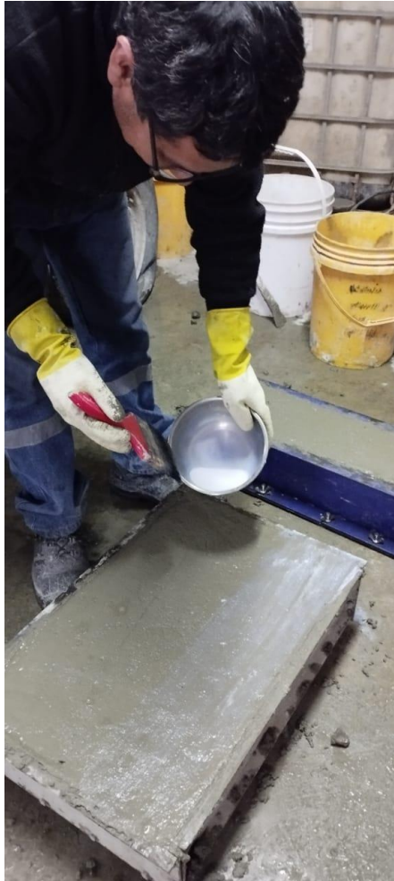
Figura 17. Aplicando el curador para sellar las fisuras generadas en el concreto
