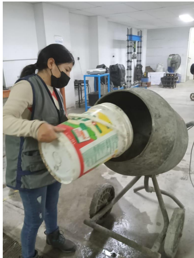
Figura 06. Colocando los agregados a la mezcladora de concreto
