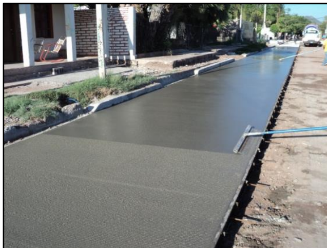
Figura 4. Consolidación del concreto en pavimento rígido
