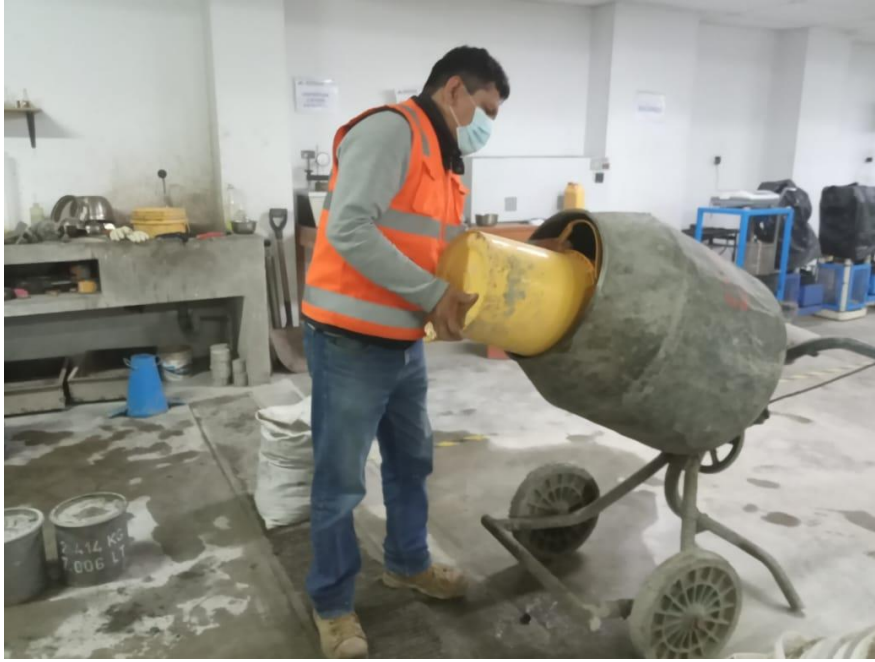
Figura 05. Colocando los agregados a la mezcladora de concreto
