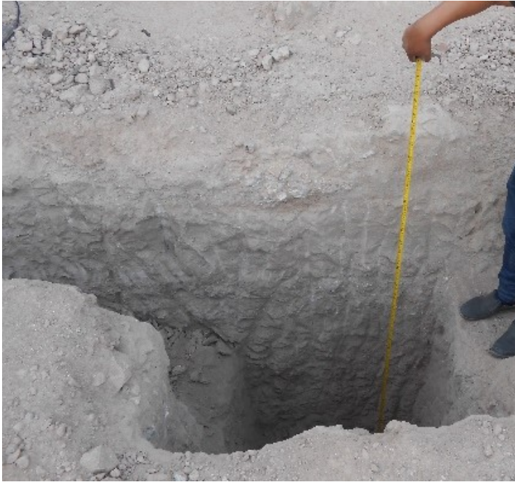
Descripción: excavación de la calicata
