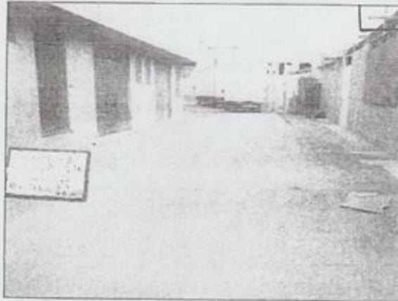
Estado actual del pasaje 1.
