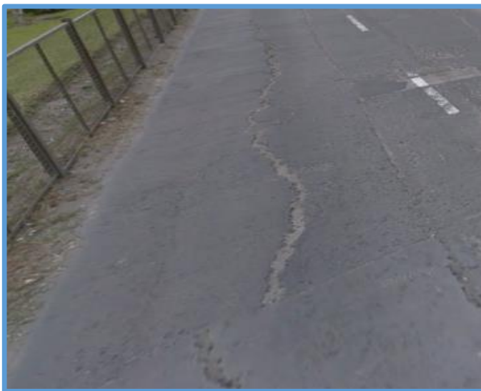
Figura 12: Grietas Parabólicas
