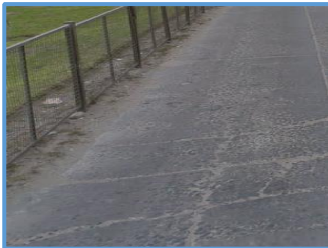
Figura 11: Grietas Transversales.
