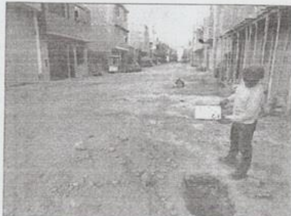
Localización en la calzada de la calicata C-2, Ca. San Cristóbal.
