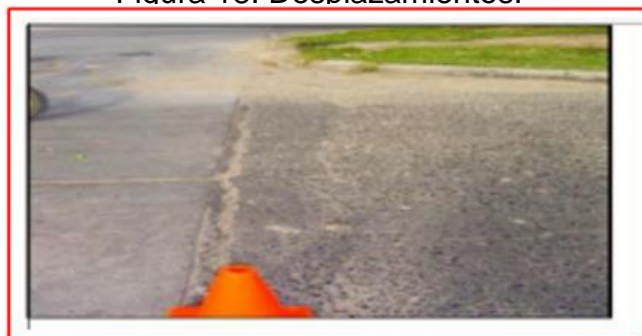
Figura 18: Desplazamientos.
