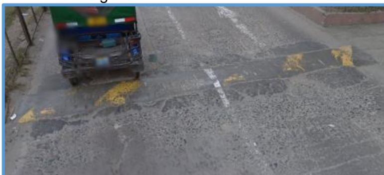
Figura 17: Ahuellamientos.
