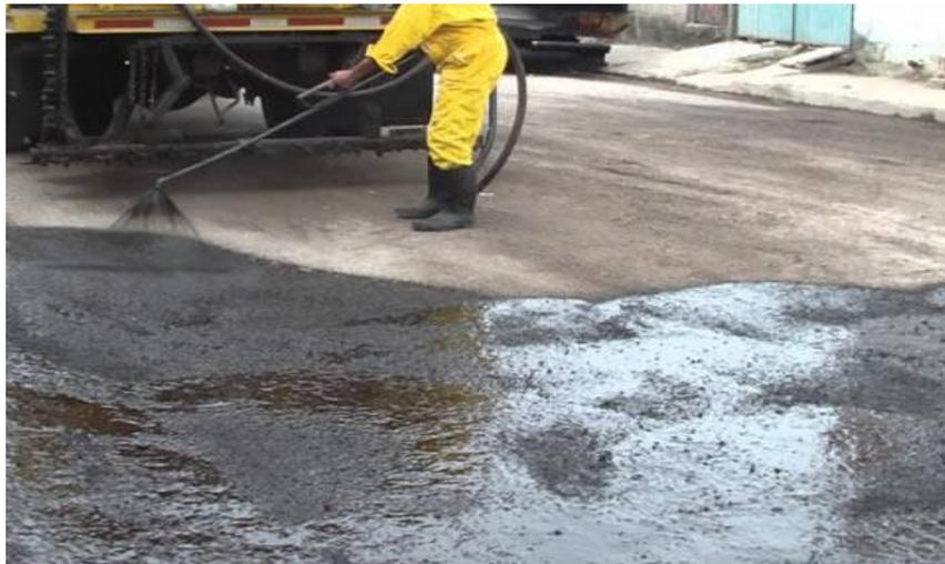
**Figura 9.** Aplicación de material bituminoso. (Asfaltos Rabbi, 2021)
