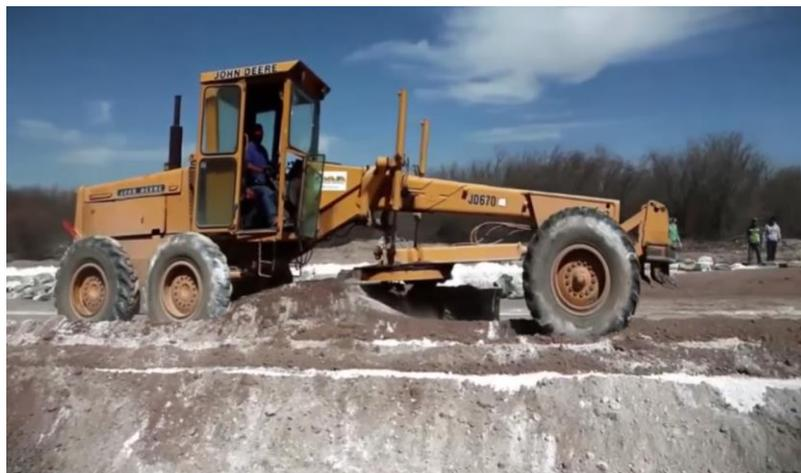
**Figura 6.** Estabilización con Cal (Horcalsa,2020)
