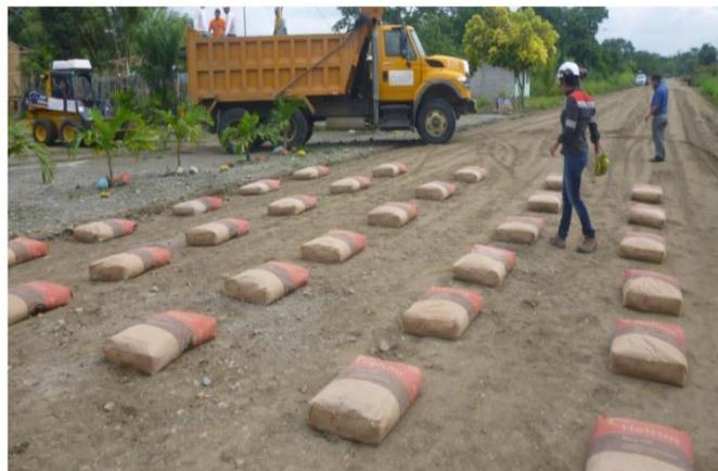
**Figura 27.** Ejemplo de aplicación de cemento para estabilización (Arce, 2016)
