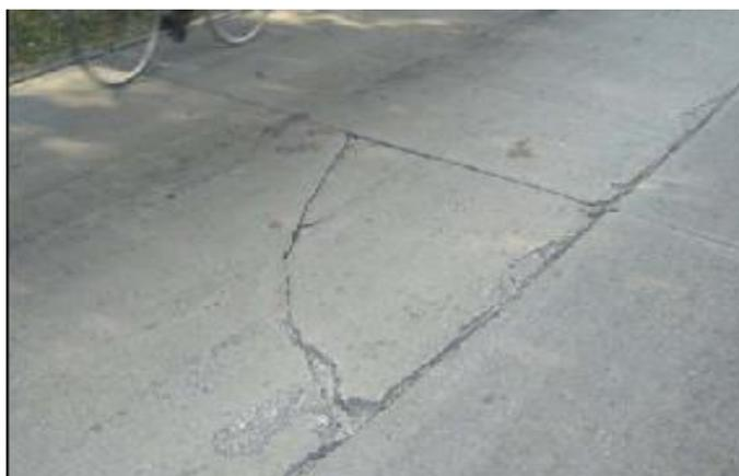
**Figura 28.** Ejemplo de fisuración en Suelo – Cemento (Gutiérrez, 2006)
