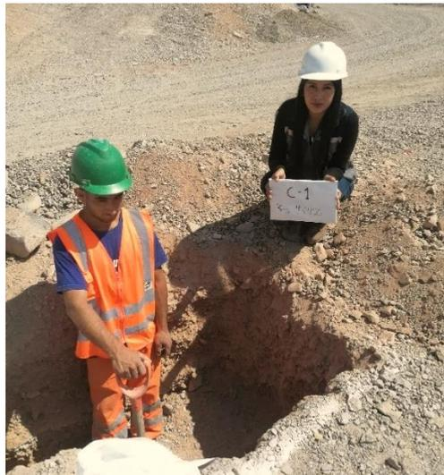
**Figura 12.** Excavación de Calicatas. (Fuente Propia)
