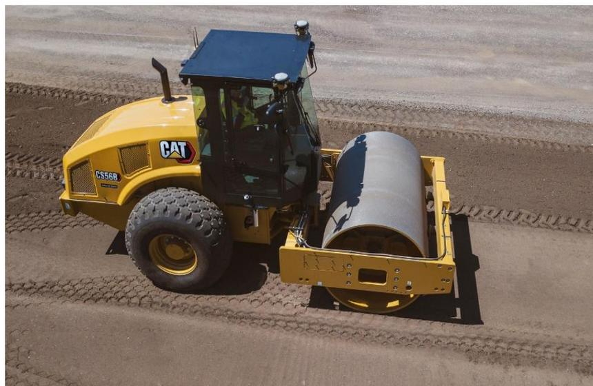
**Figura 5.** Estabilización Mecánica con Equipo Pesado. (Interempresas, 2020)
