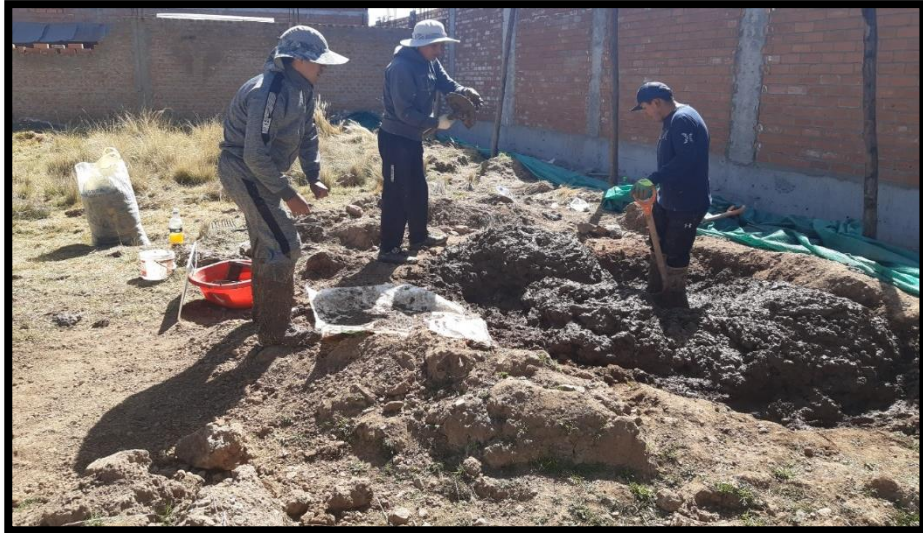
Fotografía: Mezclado del barro después de las 48 horas.
