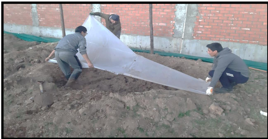
Fotografía: Tapado del material para la elaboración de adobes.
