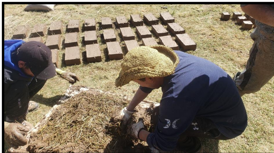
Fotografía: Adición y mezclado de la fibra de matara al 1.0%.
