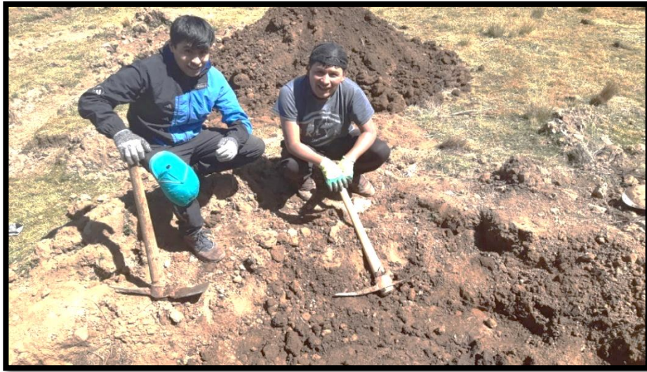
Fotografía: Excavación para el dormido del material.
