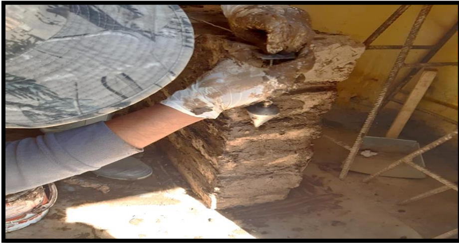
Fotografía: Verificación de la verticalidad con plomada en el murete.
