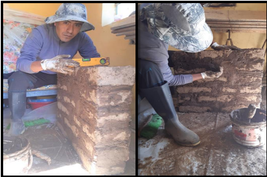
Fotografía: Verificación de nivel del murete de adobe.
