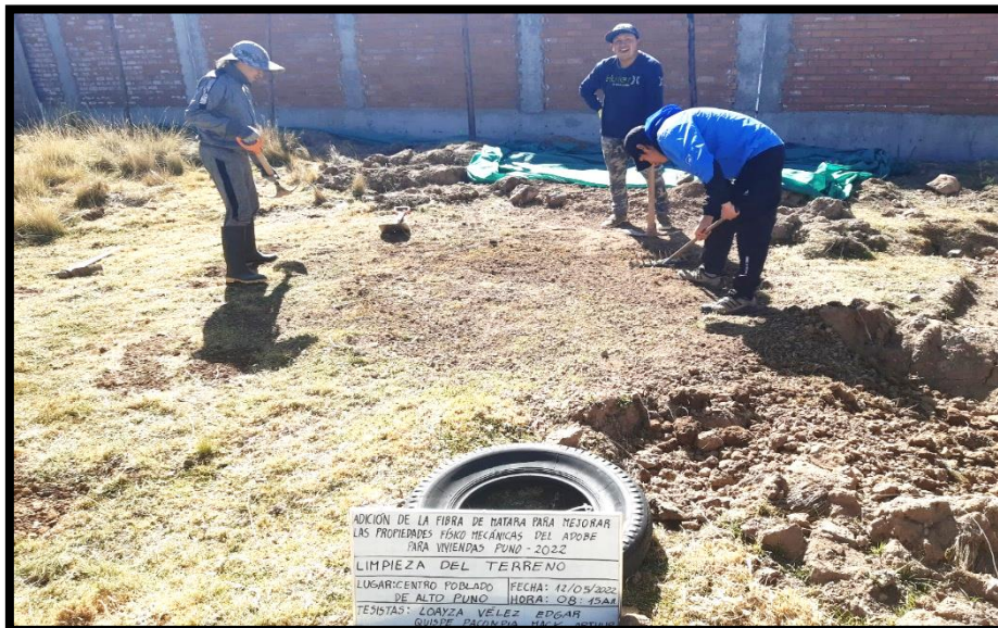
Fotografía: Limpieza de terreno para la colocación de adobes.
