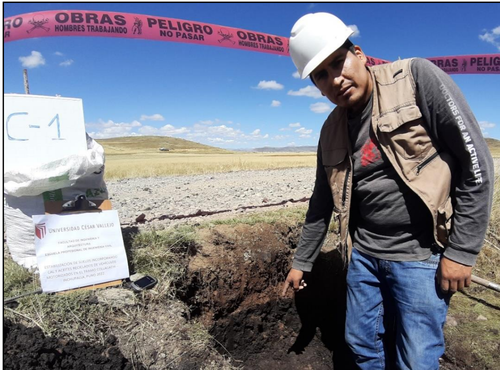
Figura 3.5. Excavación de calicatas
