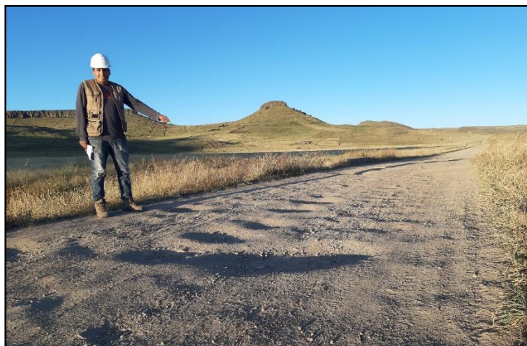
Figura 3.2. Identificación de los tramos más críticos
