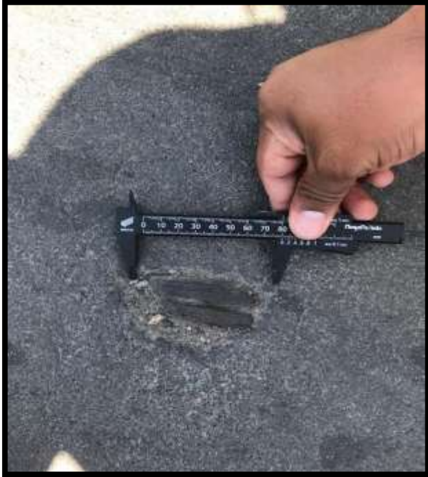
Anexo 11: Medición de las fallas
