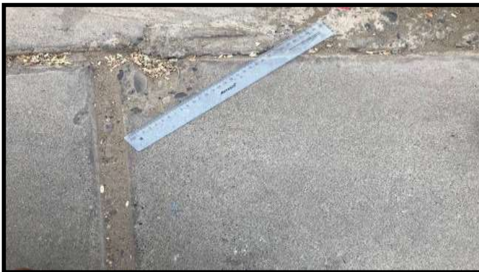
Anexo 4 : Tipo de falla fisura de borde
