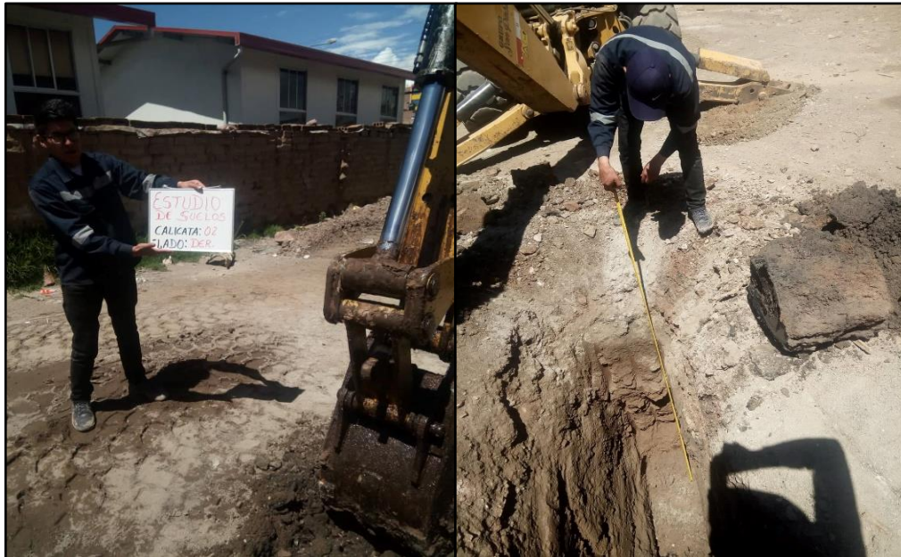
Figura 12. Extracción de muestras para laboratorio
