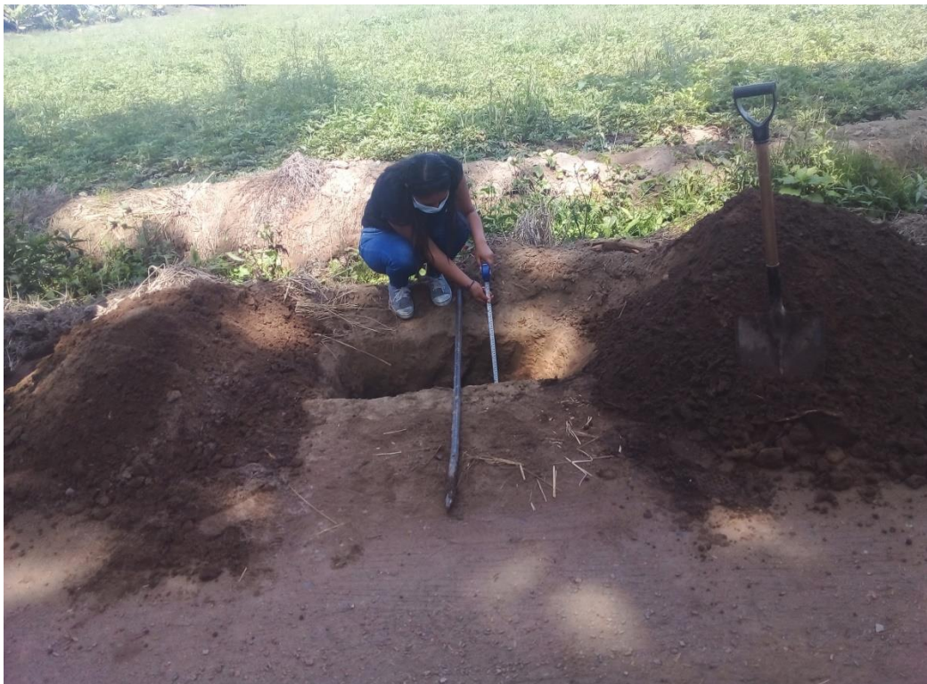
Figura 5: Calicatas con 1.50 m de profundidad.
