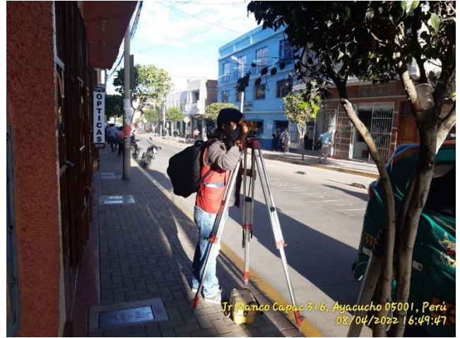
Figura 8. Levantamiento topográfico de la ciclovia. Fuente: elaboración propia.
