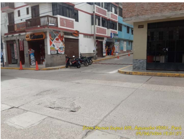
Figura 15. Vista de una intersección con reductores de velocidad. Fuente: elaboración propia.
