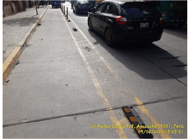
Figura 18. Vista de separadores y bolardos dañados parcial y totalmente. Fuente: elaboración propia.
