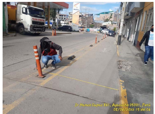
Figura 6. Medida de la sección de la ciclovia Fuente: elaboración propia.
