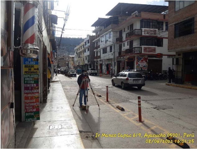
Figura 7. Levantamiento topográfico de la ciclovia. Fuente: elaboración propia.
