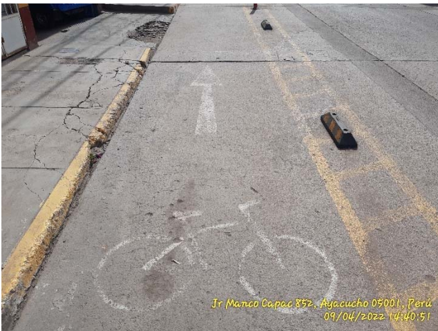
Figura 13. Demarcación del sentido de circulación. Fuente: elaboración propia.
