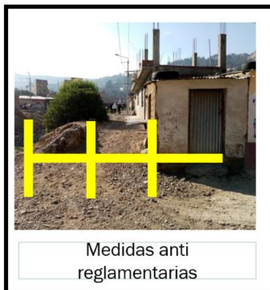
Figura 19: Medidas antirreglamentarias según la norma th050
