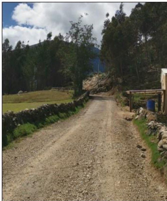
Vía con muro bajo
