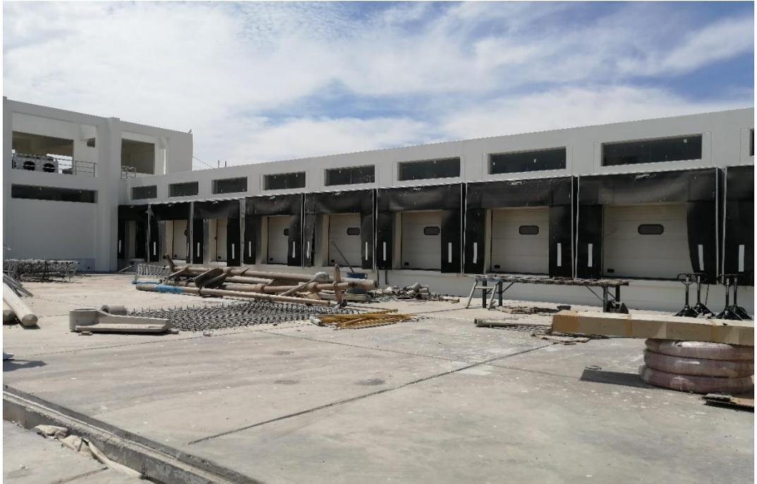
Nota: en la figura se muestra la no existencia de un material elastomérico entre paños
