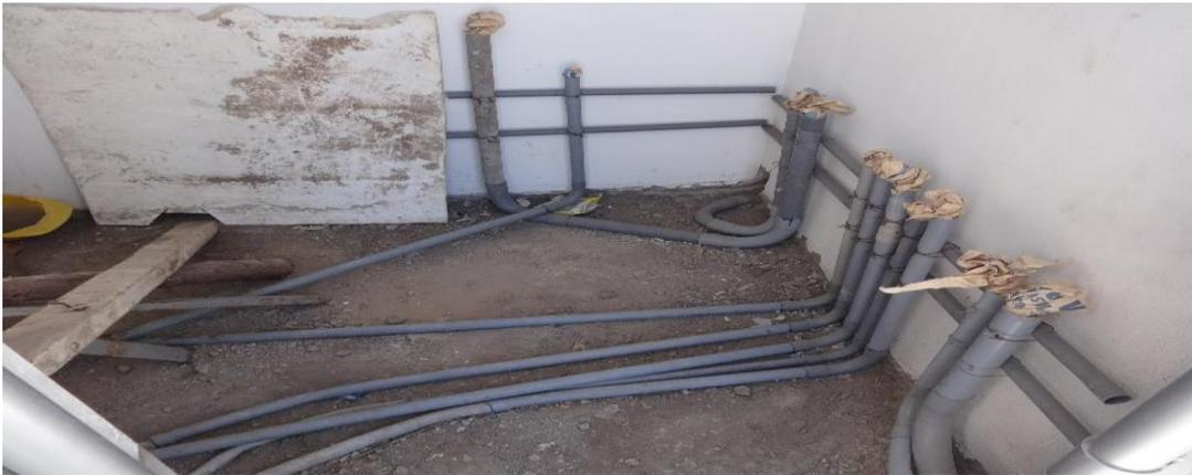
Nota: En la figura se muestra el Tendido de tuberías de PVC en planta de tratamiento de aguas residuales
