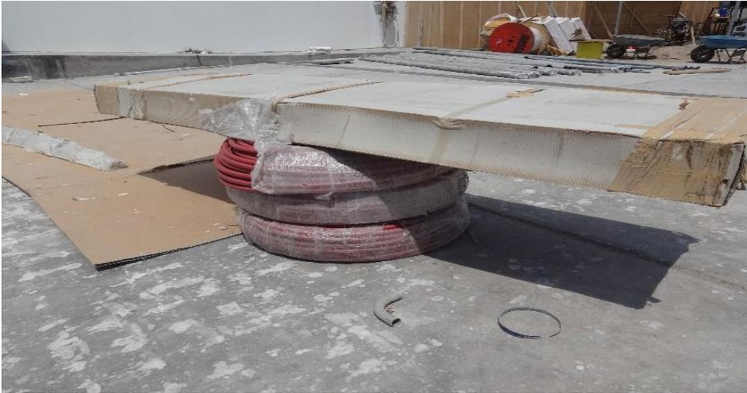
Nota: En la figura se muestra Cable de media tension de tipo N2XSY, en patio de maniobra
