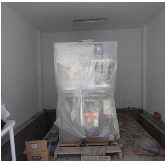
En la S.E. se encuentra la Celda de Protección en media tensión, de la Marca SAREL procedencia de Italia, según se muestra en la Fig. N°24
