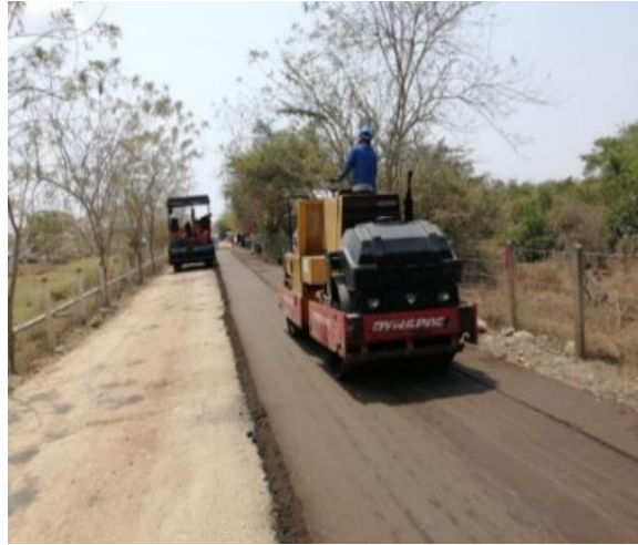
Figura 2. Compactación del suelo
