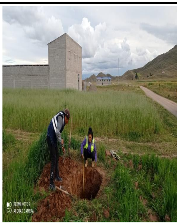
Figura 02. Profundidad de la calicata 1
