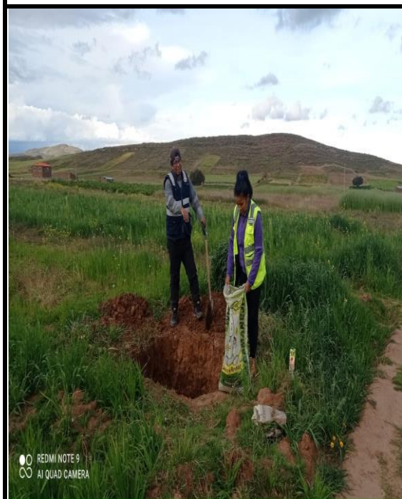
Figura 03. Extracción del material de la calicata 1
