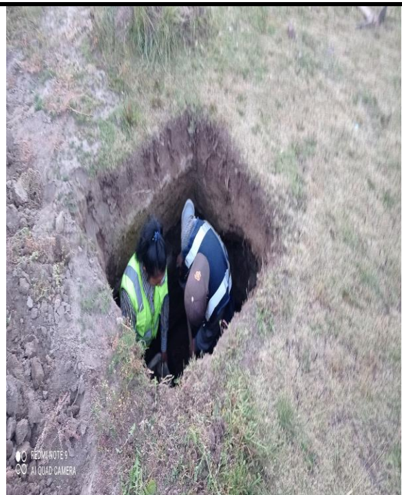
Figura 06. Extracción de material de la calicata 3
