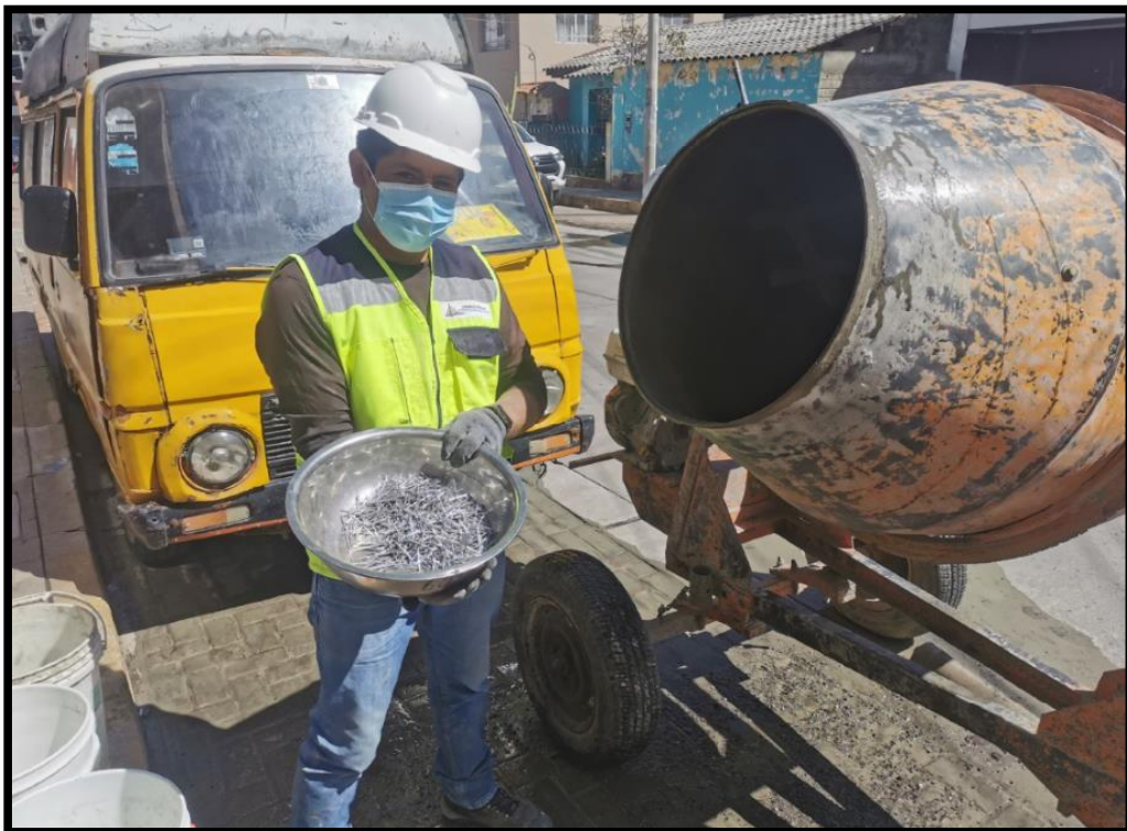
Imagen N° 12: Adición de las Fibras cortas de Acero al momento del Mezclado.
