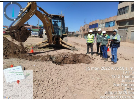
Fotografía 4. Identificación de la profundidad 1.50 metros por debajo de la rasante C-1
