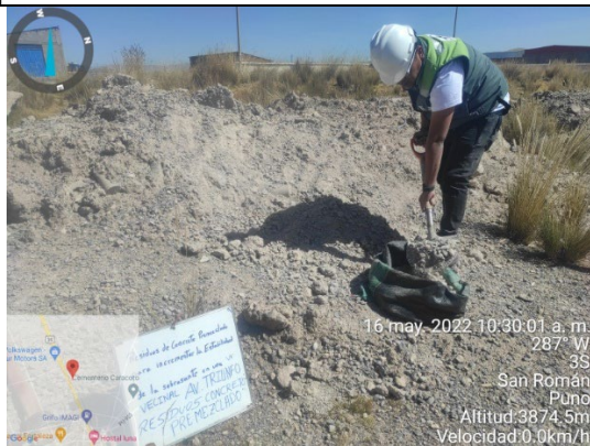
Fotografía 9. Recolección de los residuos de concreto premezclado
