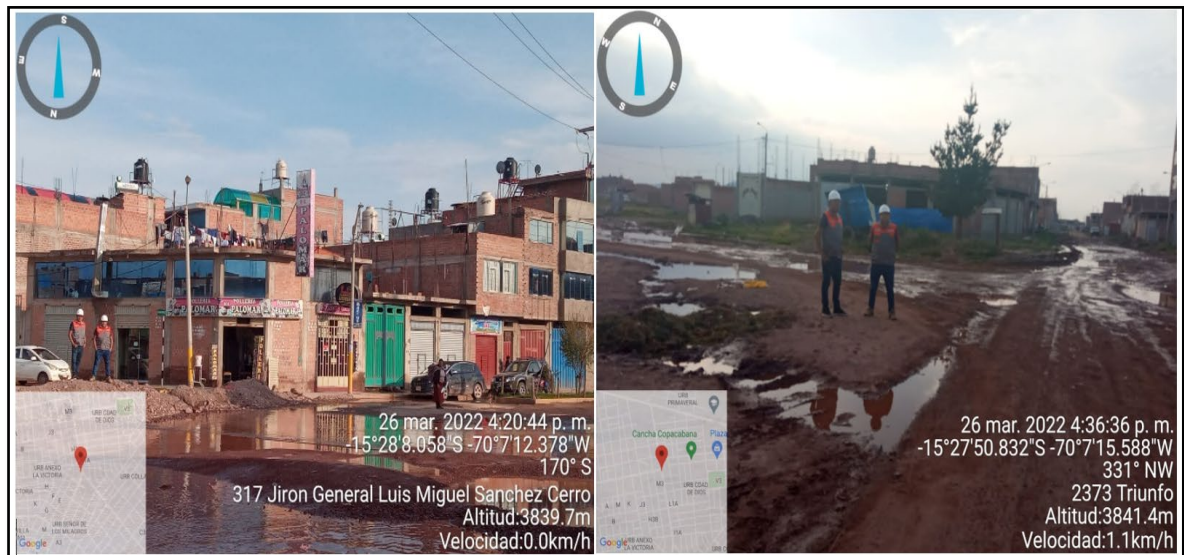
Figura 2. Situación actual de la vía - Avenida Triunfo
