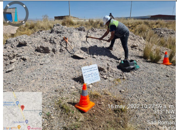
Fotografía 8. Inicio de la extracción del material residuos de concreto premezclado
