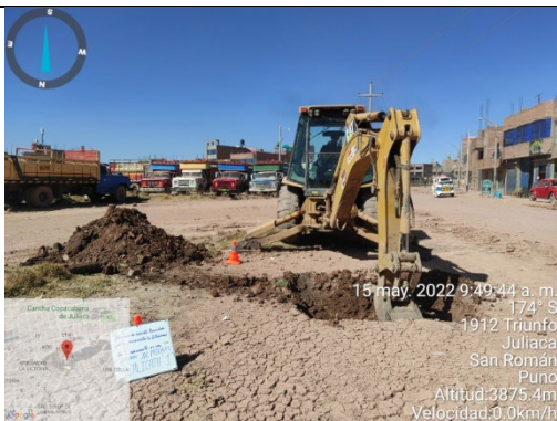
Fotografía 3. Excavación de la calcata
