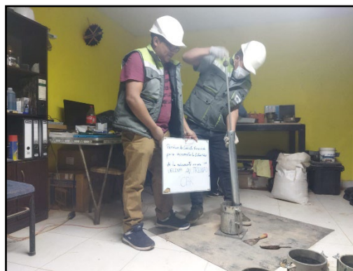
Figura 13. Ensayo de Proctor modificado.
