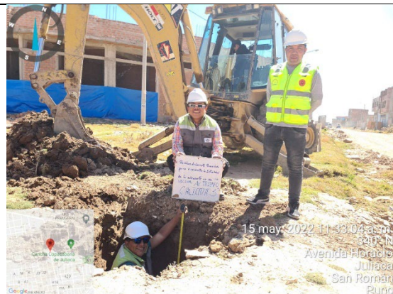
Fotografía 5. Identificación de la profundidad 1.50 metros por debajo de la rasante C-2
