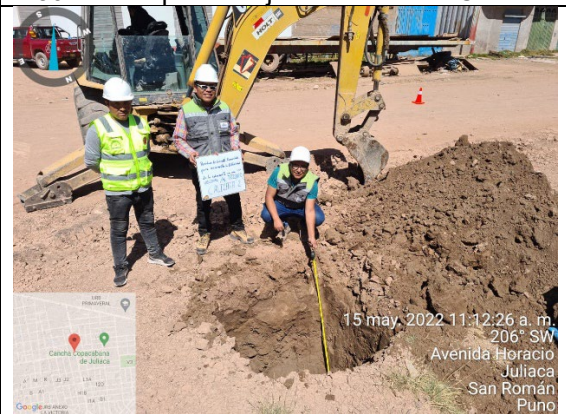
Fotografía 6. Identificación de la profundidad 1.50 metros por debajo de la rasante C-3
