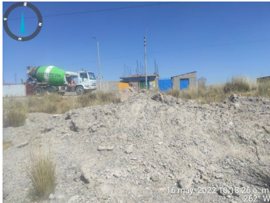
Fotografía 7. Identificación de lugar de extracción de los residuos de concreto premezclado.
