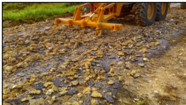
Figura 7. Estabilización de subrasante.
