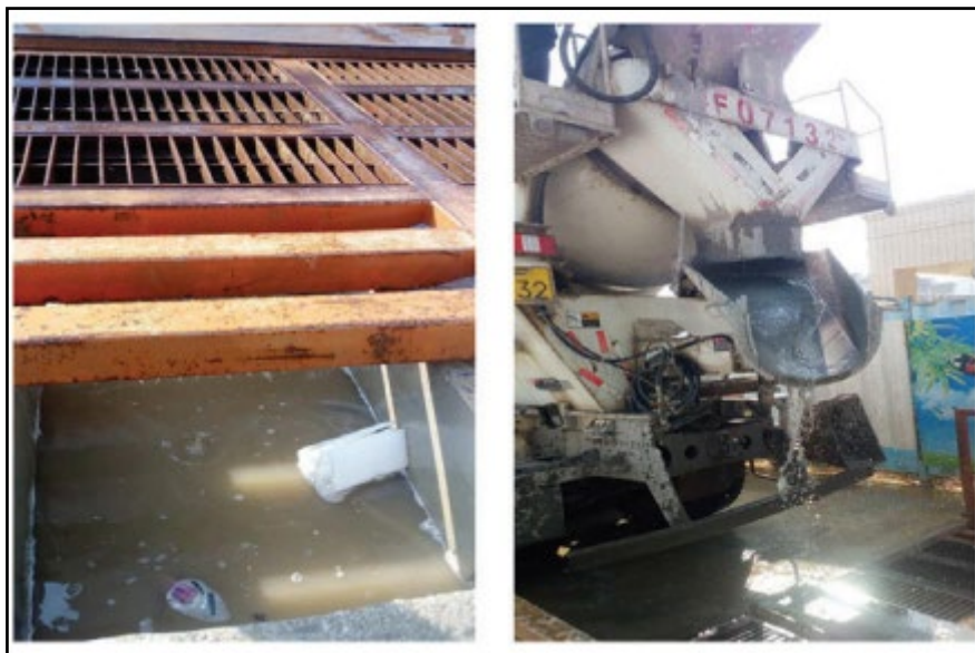
Figura 1. Generación de residuos de hormigón fresco
