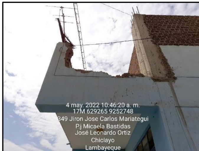
Figura 38. Estado de Pabellón 01
