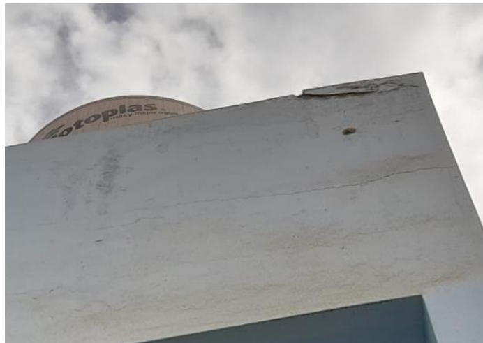
Figura 18. Fractura de tanque elevado
