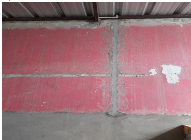
Figura 24. Muro dividido por tubería - Cocina
