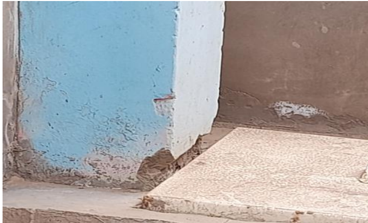
Figura 19. Columna reducida en base – Tanque elevado
