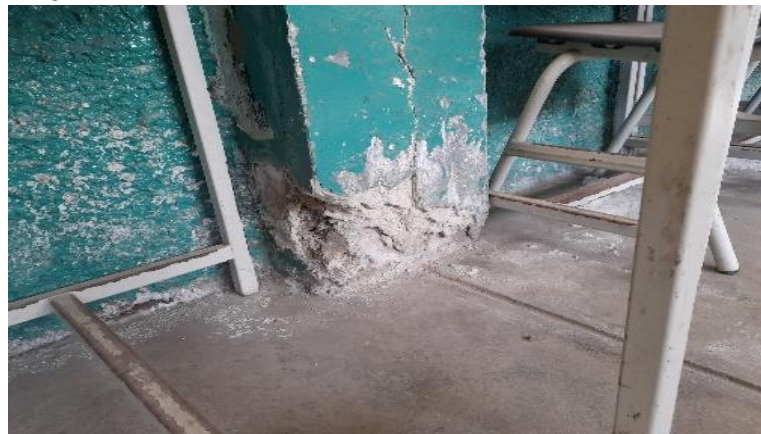
Figura 10. Columna reducida en base – Pabellón 03
