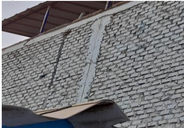
Figura 15. Muro dividido - SS.HH.
