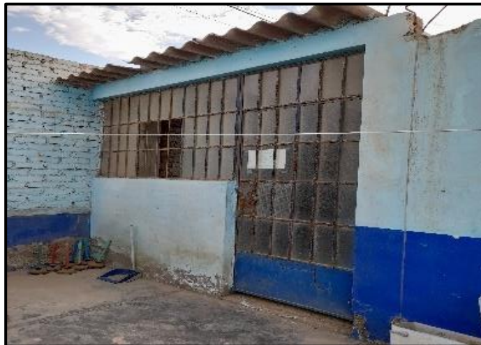
Figura 49. Vista frontal de almacén a demoler
