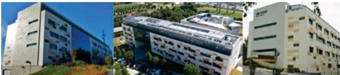
Figura 10: Los edificios conservan un valor horizontal.
