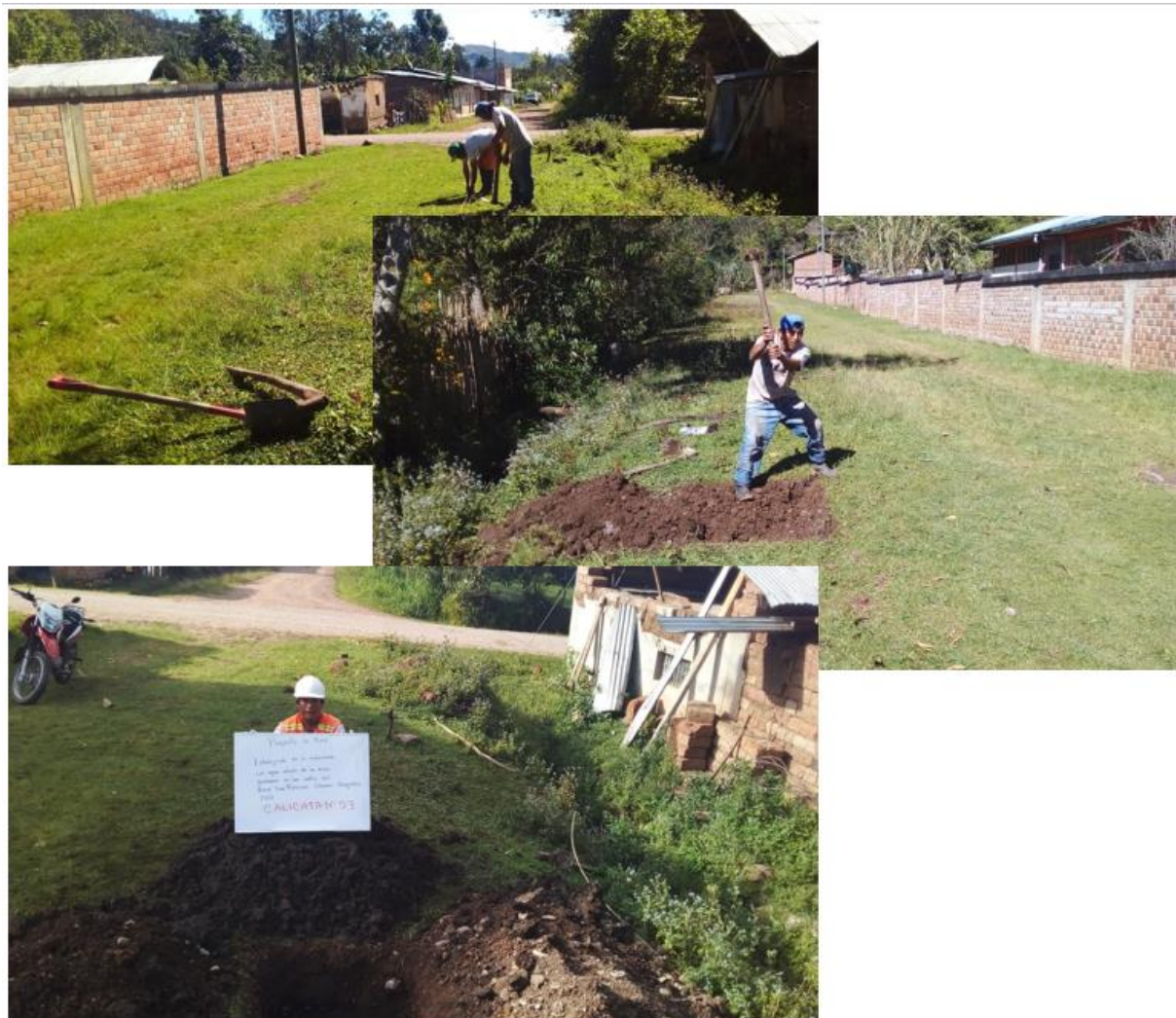
Figura 14. A continuación presentamos los trabajos realizados en la calicata N° 03
