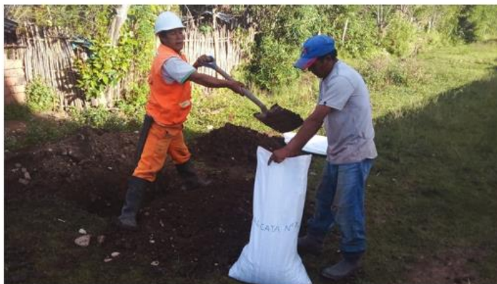
Figura 15. Toma de muestras de la calicata N° 03
