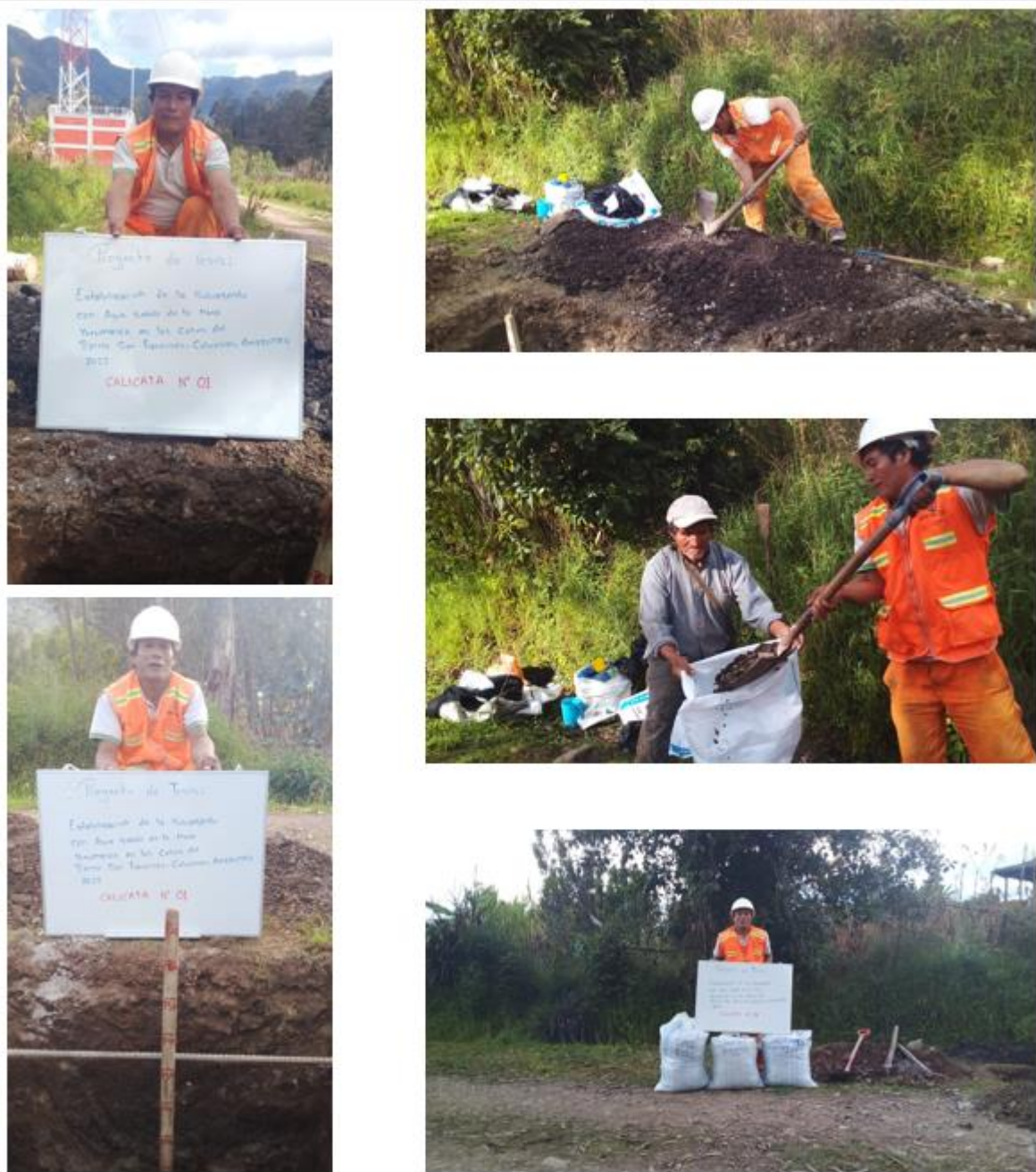
Figura 10. A continuación presentamos, los trabajos realizados en la calicata N° 01
