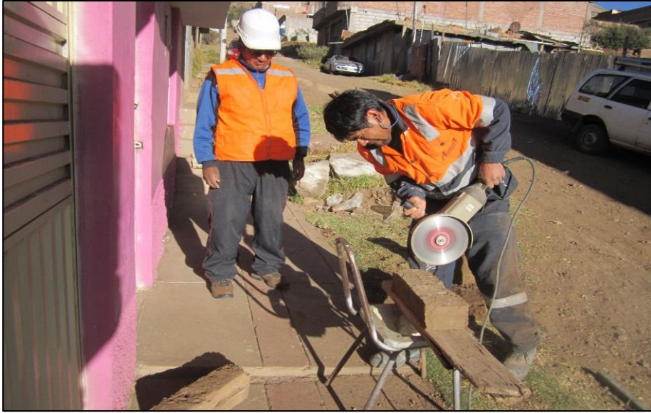
Figura 11. Obtención de muestras para la prueba de compresión de adobe nuevo.
