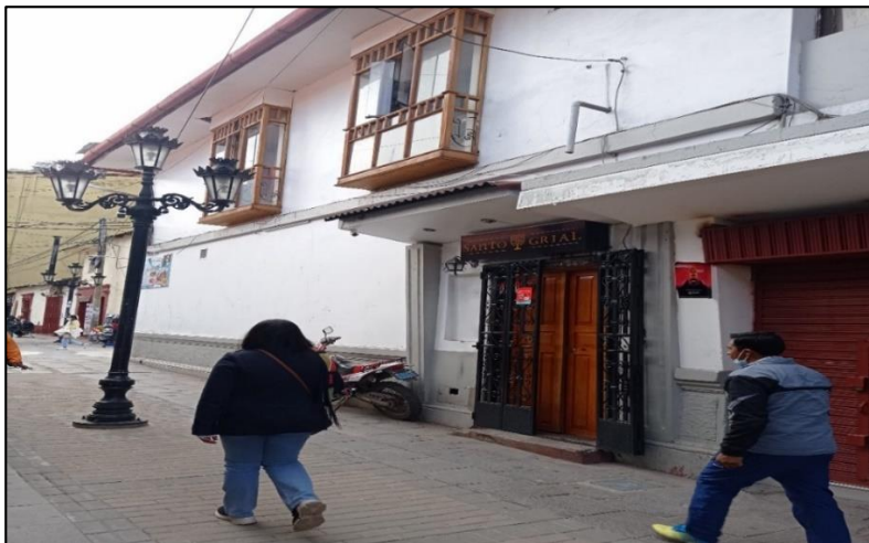
Figura 6. Edificación rústica de dos niveles que sirve de muestra, ubicado entre el jr. Lima y pje. Grau de la ciudad de Puno. Fuente. propia.
