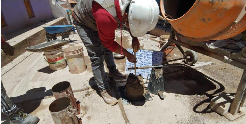
Fotografía 5 Determinación del SLUMP, concreto + Ceniza de horno de ladrillera.
