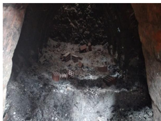
Figura 5: Horno de ladrillera - Ceniza
