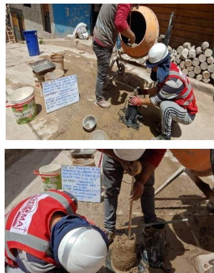
Figura 17: Medición del SLUMP
