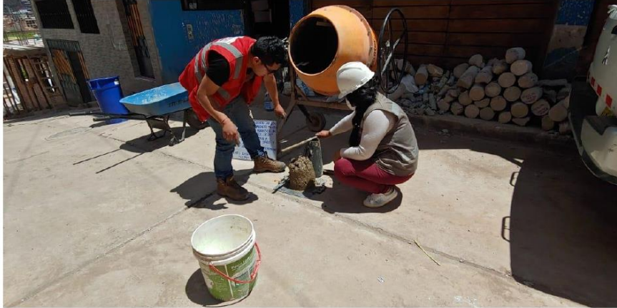
Fotografía 1 Determinación del SLUMP, concreto patrón.
