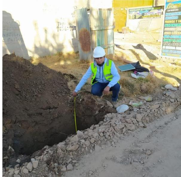
**Panel fotográfico N° 6:** Excavación de una profundidad de 150cm de altura del Jirón La victoria.
