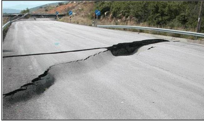
*Figura 12.* Defecto del pavimento en la carretera
