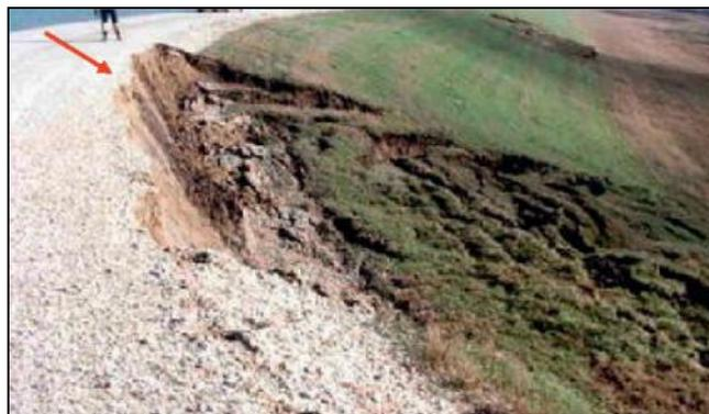
*Figura 11.* Falla de la pendiente del terraplén causado por suelo expansivo.
