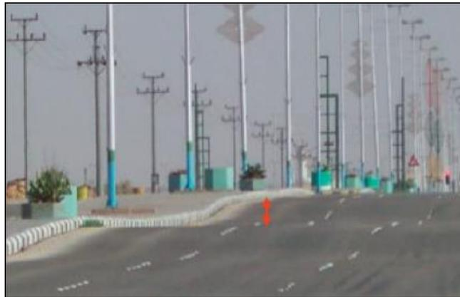
*Figura 10.* Levantamiento de pavimento flexible debido al suelo expansivo.
