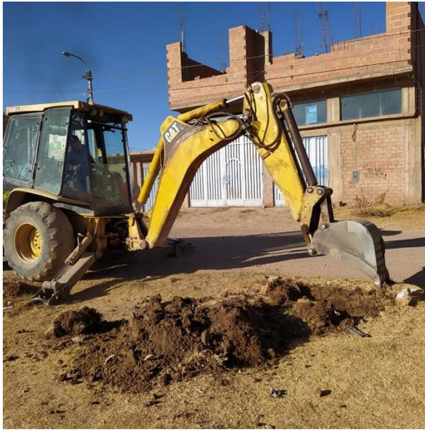
**Panel fotográfico N° 1:** Inicio de la excavación de la Calicata N° 01 del Jirón La victoria.
