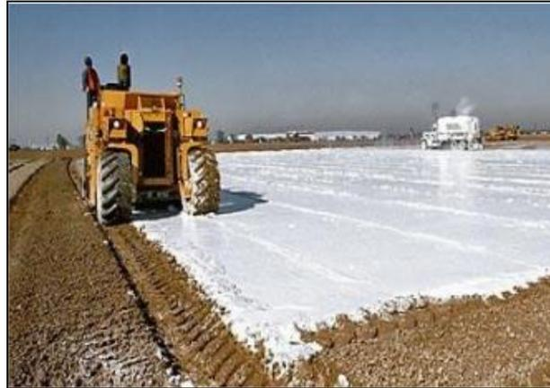
Figura 15. Proceso de estabilización química en la construcción de vías.
