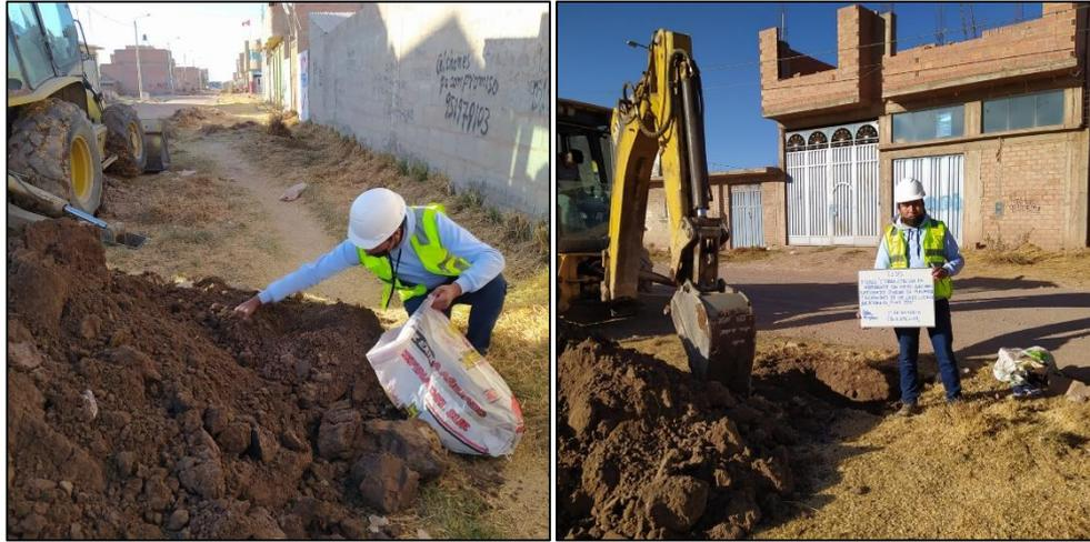
*Figura 20.* Obtención de muestras del Jirón La victoria.
