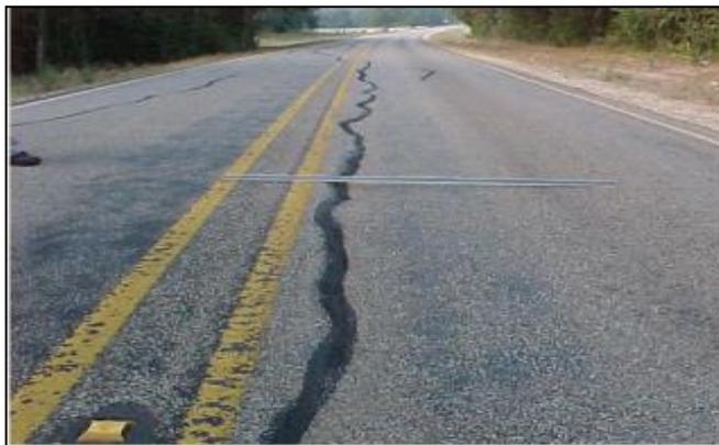
*Figura 13.* Grieta longitudinal típica en pavimentos sobre arcillas expansivas
