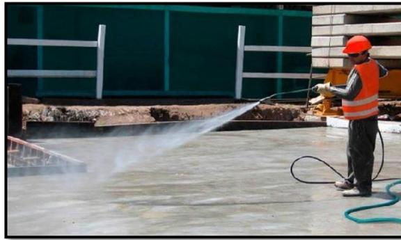
*Figura 9: Curado del concreto.*
