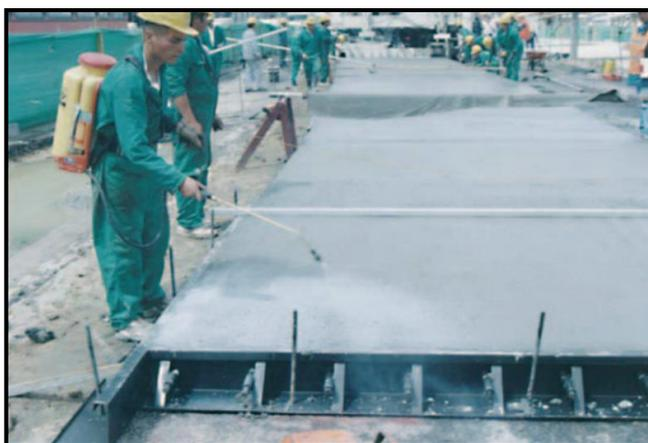
*Figura 10: Aplicación del curado con aditivo.*
