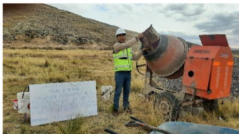
Dosificación del diseño de mezcla para una resistencia de 210kg/cm<sup>2</sup>
