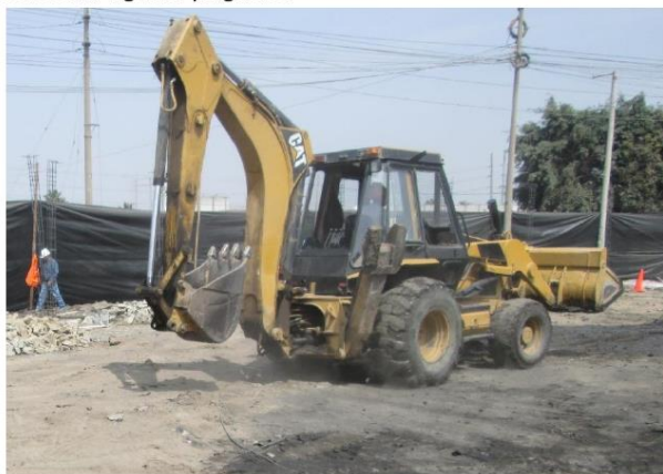
Figura 2. Maquinaria pesada en la obra
