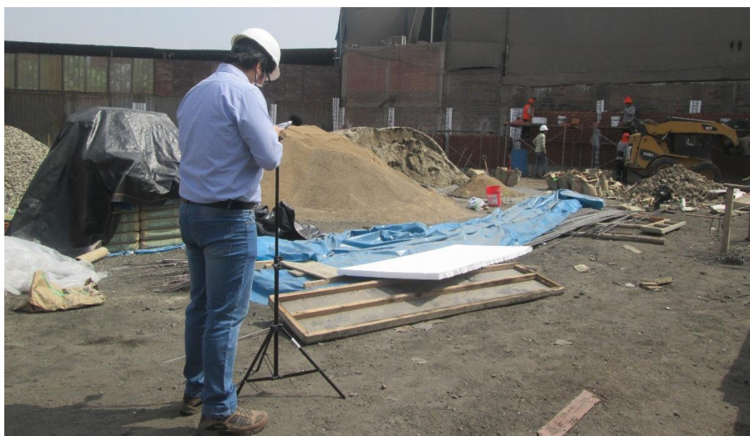
Figura 8. Inspección programada en la obra de construcción de depósito municipal
