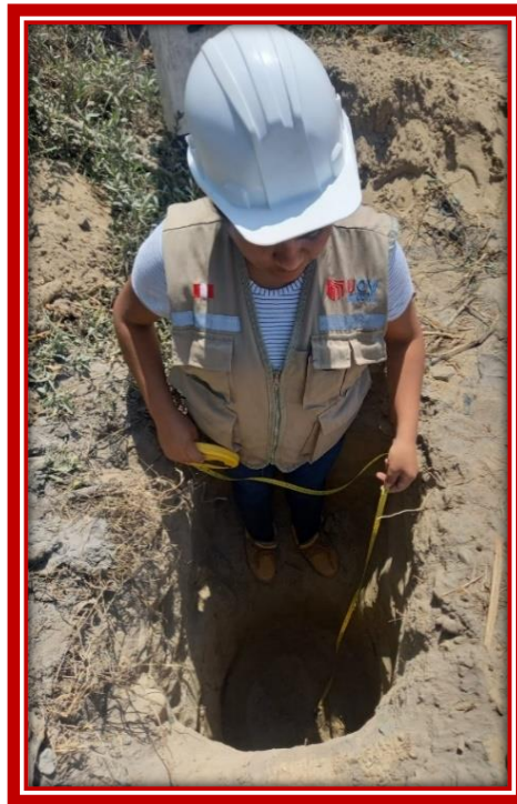
FIGURA N° 9 ELABORACIÓN DE LA C3 TRAMO KM 9+000
