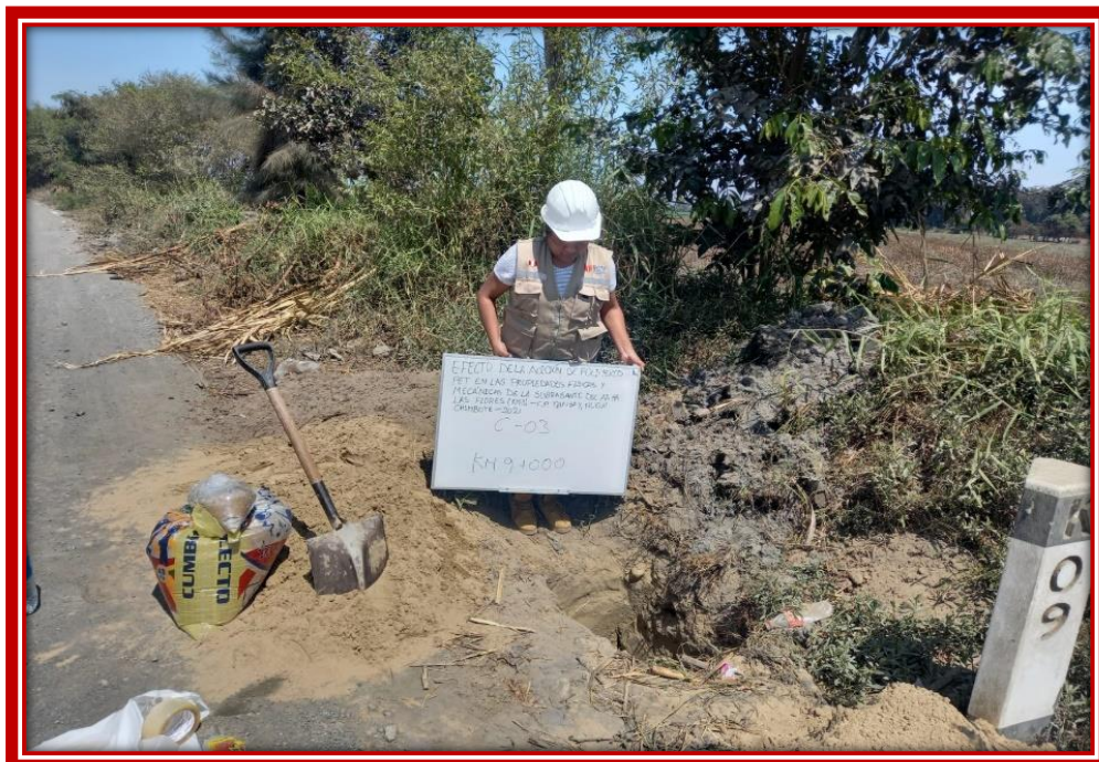
FIGURA N° 10 EXTRACCIÓN DE MUESTRA DE LA C3 TRAMO KM 9+000
