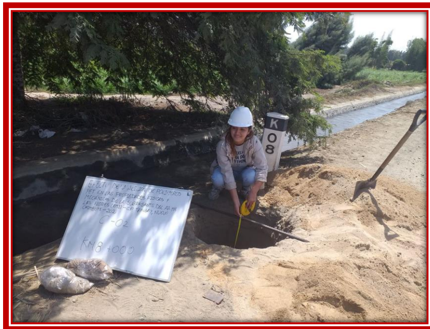
FIGURA N° 8 EXTRACCIÓN DE MUESTRA DE LA C2 TRAMO KM 8+000
