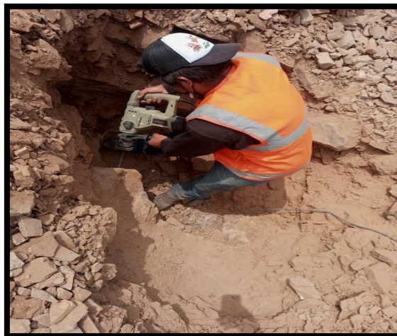
IMAGEN 3: se observa la excavación de la calicata.
