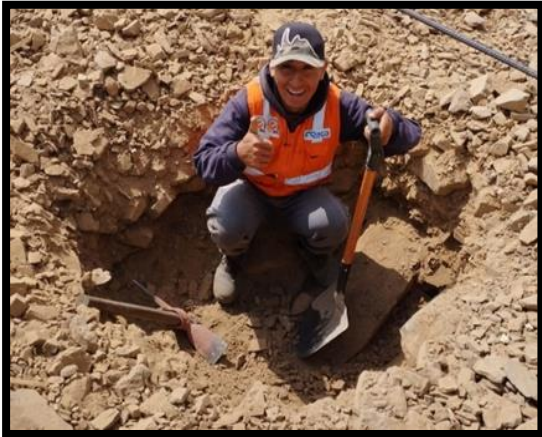
IMAGEN 1: se observa la excavación de calicata.
