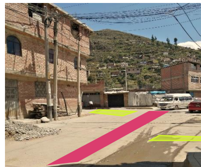
Avenida 8 de Marzo, a la derecha una intersección con el Jr. 21 de Diciembre y a la izquierda otra intersección con otro pasaje S/N.
