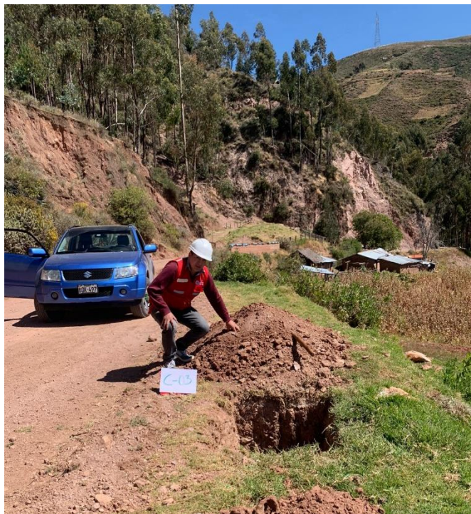
Figura 16. Calicata 3 de 1.5m de profundidad
