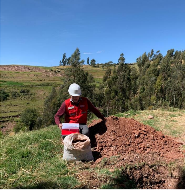
Figura 1. Calicata 1 en la progresiva 0+750
