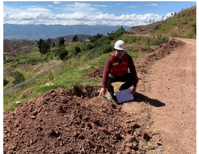
Figura 4. Calicata 4 en la progresiva 4+500
