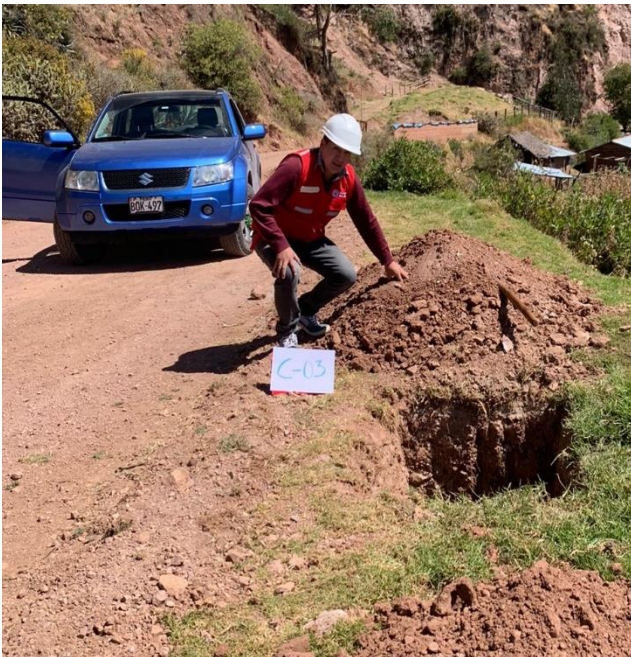
Figura 3. Calicata 3 en la progresiva 3+020
