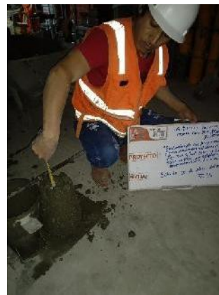
Foto 8. Asentamiento 7% de PVC
